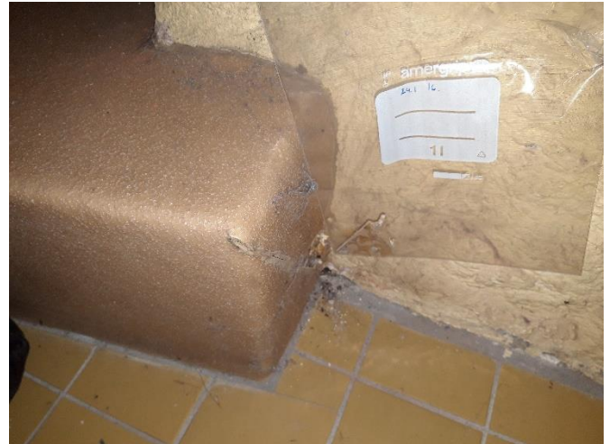
Kuva 16. Materiaalinäyte 16. Kellarin portaat. Matto/liima.
