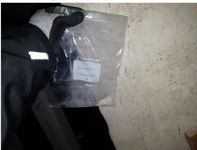
Kuva 73. Materiaalinäyte 78. Ullakko. Hormin tasoite.
