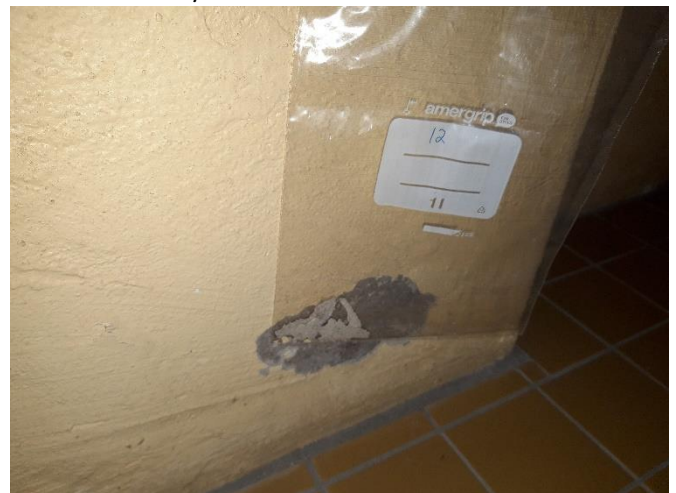
Kuva 12. Materiaalinäyte 12. Kellarin käytävä. Seinä. Tasoite/maali.
