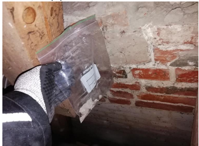
Kuva 74. Materiaalinäyte 80. Ullakko. Seinä. Muurauslaasti.
