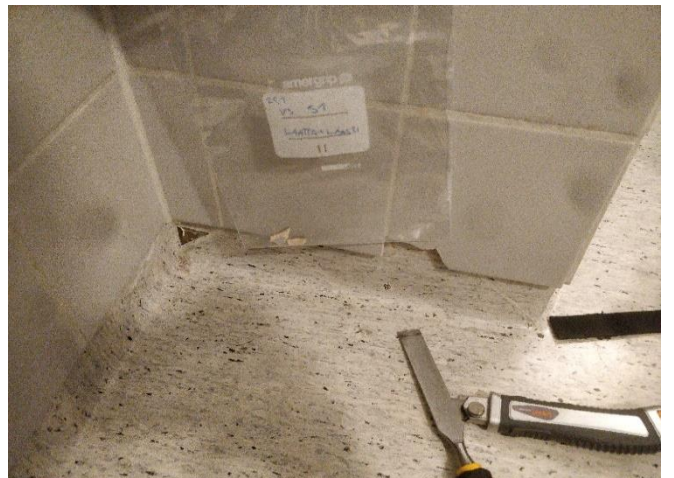
Kuva 50. Materiaalinäyte 52. 2.krs. WC. Seinä. Laatta/laasti.
