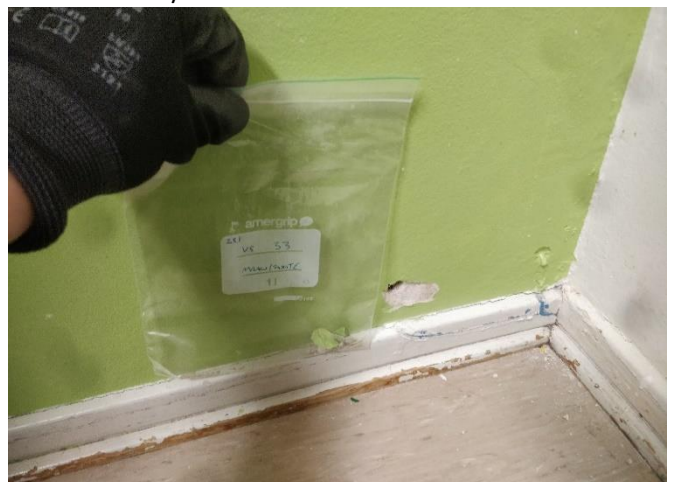
Kuva 32. Materiaalinäyte 33. 1.krs. Seinä. Maali/tasoite.
