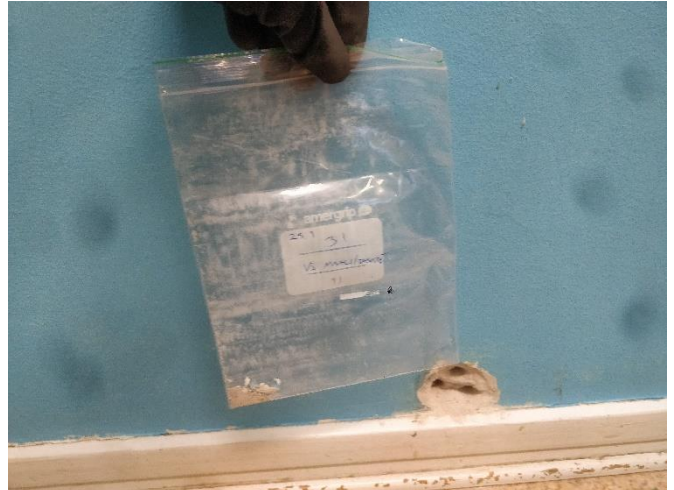
Kuva 30. Materiaalinäyte 31. 1.krs. Seinä. Maali/tasoite.
