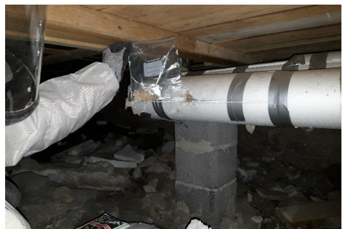
Kuva 8. Materiaalinäyte 8. Ryömintätila. Putkieriste.
