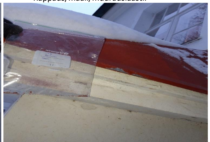
Kuva 62. Materiaalinäyte 67. Julkisivu. Vesikatto. Maali.
