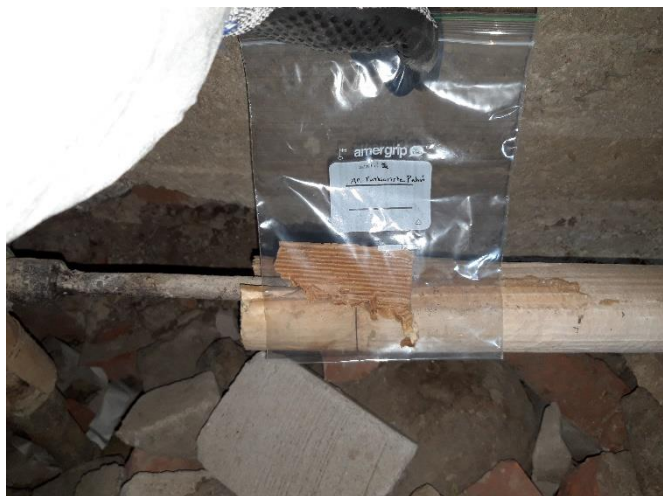
Kuva 2. Materiaalinäyte 2. Ryömintätila. Putkieriste.
