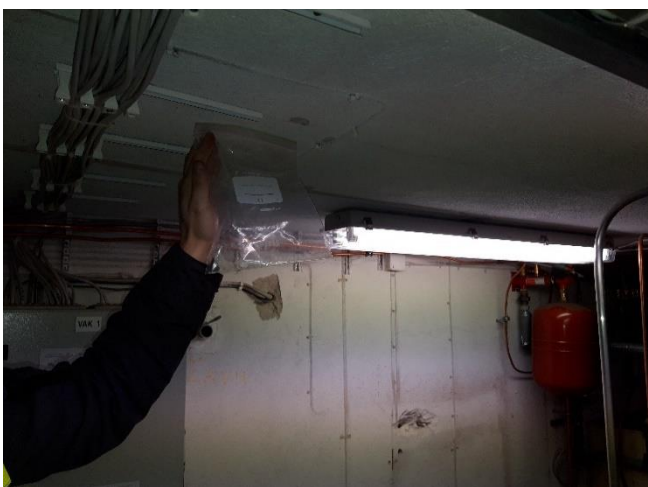
Kuva 67. Materiaalinäyte 72. Pannuhuone. Katto. Tasoite. Pinnoite.
