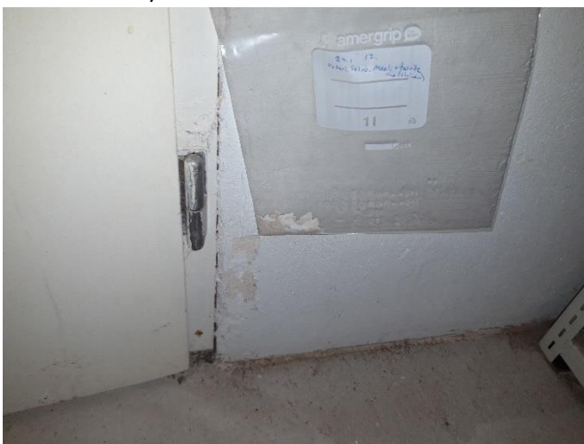
Kuva 11. Materiaalinäyte 11. Kellari. Seinä. Tasoite/maali.
