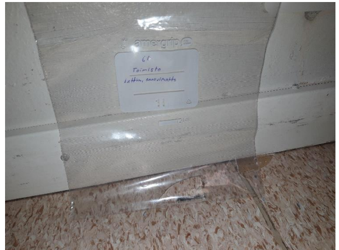
Kuva 58. Materiaalinäyte 60. 1.krs. Lattia. Matto.
