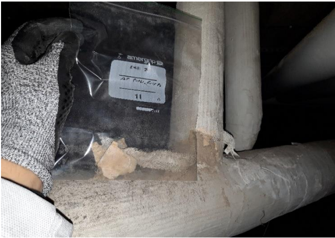
Kuva 3. Materiaalinäyte 3. Ryömintätila. Putkieriste
