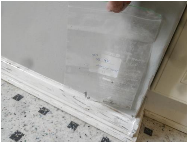
Kuva 45. Materiaalinäyte 47. 2.krs. Seinä. Maali/tasoite.
