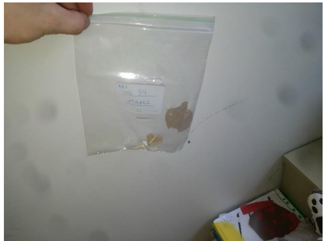
Kuva 52. Materiaalinäyte 54. 2.krs. Seinä. Maali/tasoite.
