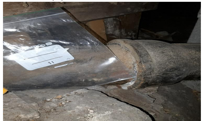
Kuva 6. Materiaalinäyte 6. Ryömintätila. Valurautaviemärin tiivistemassa.
