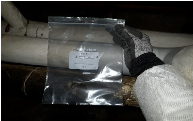
Kuva 5. Materiaalinäyte 5. Ryömintätila. Putkieriste.
