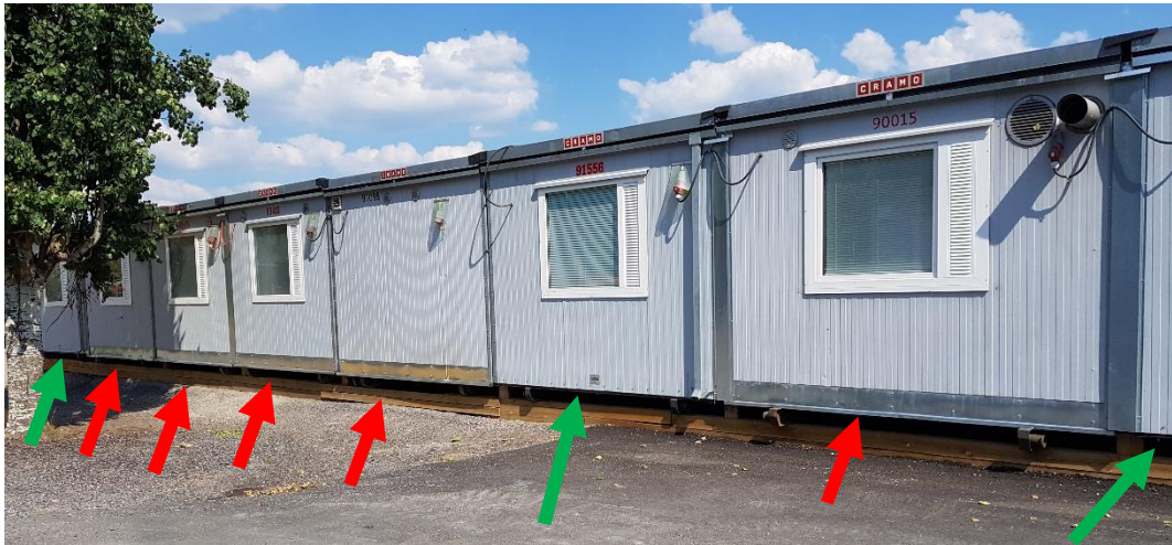
Kuva 6. Havaintojen perusteella moduuliyksiköissä, joissa on teräslista (punainen nuoli), on mineraalivillaeristeinen alapohja ja muissa moduuliyksiköissä on uretaanieristeinen alapohja (vihreä nuoli).
