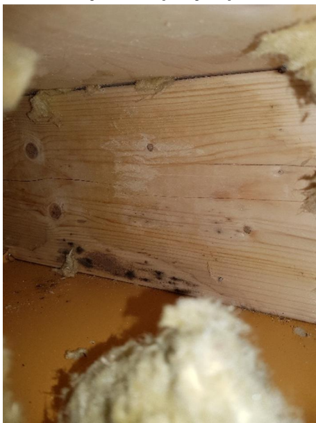
Kuva 9. Yhdessä kohdassa havaittiin tummaa pilkkua lattiapalkissa (AP4). Rakenteessa ei ollut koholla olevaa kosteuspitoisuutta.
