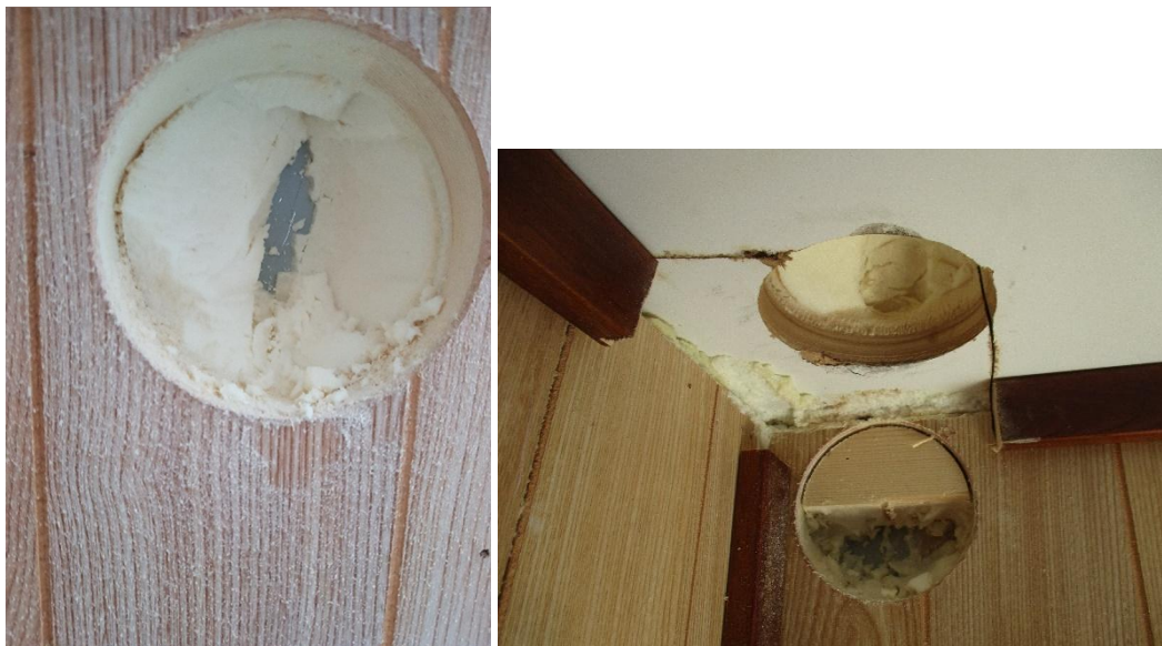
Kuva 14. Kuvia ulkoseinän rakennearauksista.
