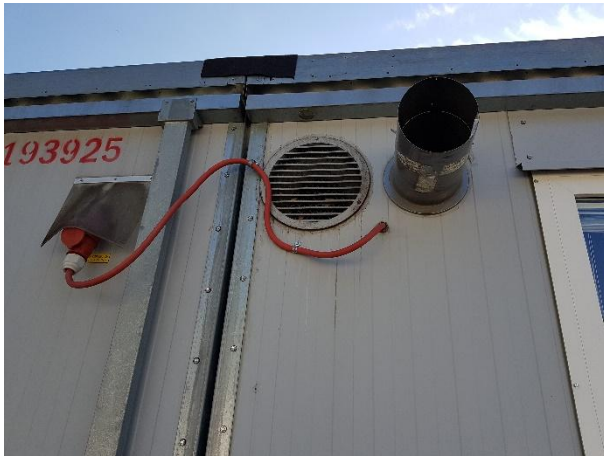
Kuva 19. Vesikatolla moduulien välissä on bitumihuopakaista.
