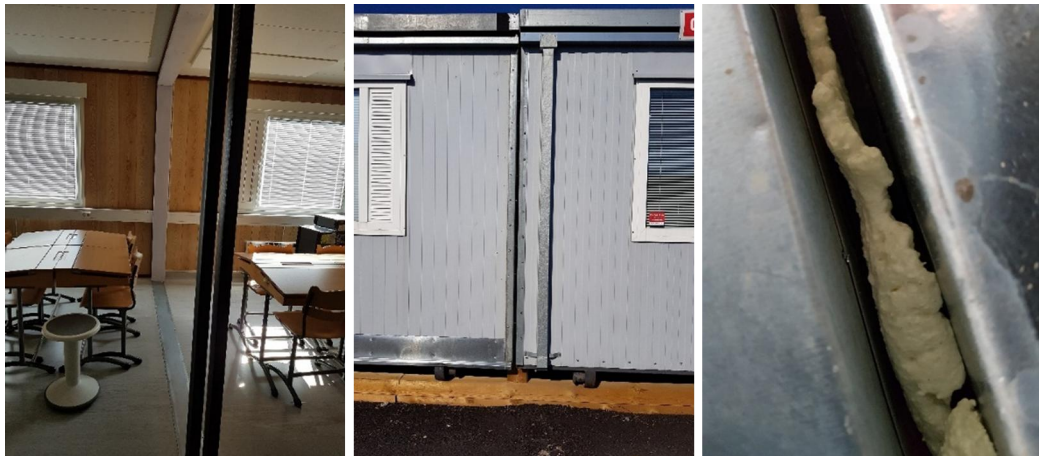
Kuvat 11 a-c. Moduulien välit on peitetty sisäpuolelta metallilistoilla (a). Alapuolelta tarkasteltuna moduulivälejä on tiivistetty uretaanilla.
