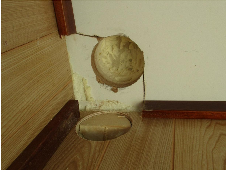
Kuva 17. Kuva yläpohjan rakenneavauksesta.
