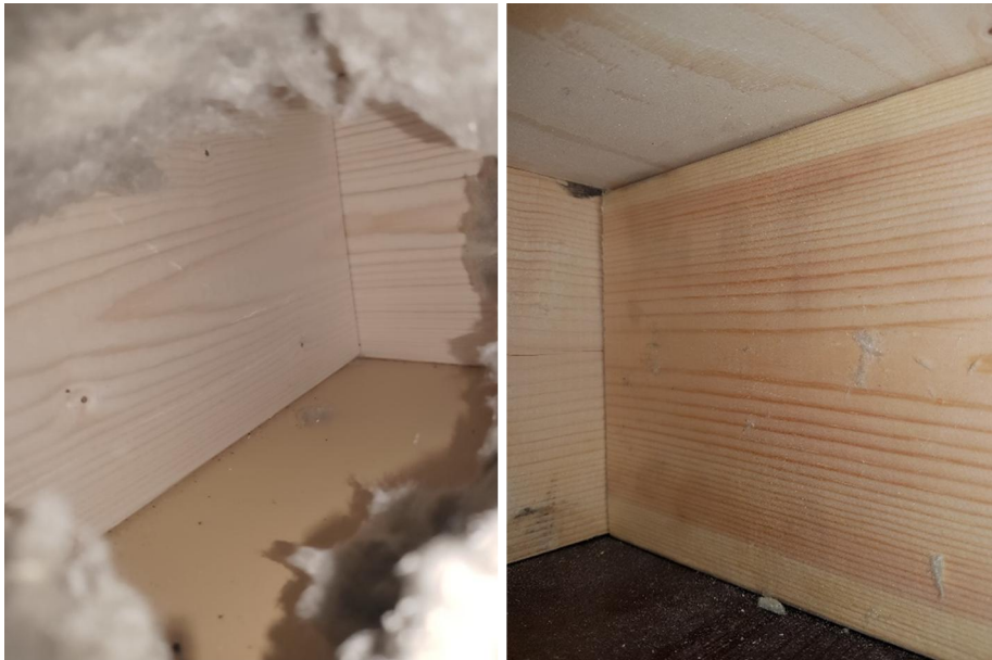
Kuvat 8 a ja b. Alapohjan puurakenteet ja mineraalivilla olivat hyväkuntoisia.
