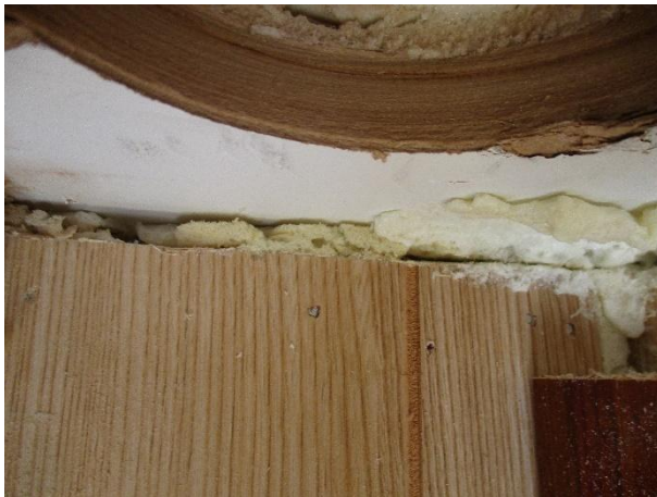
Kuva 18. Ulkoseinän ja yläpohjan liitos on tiivistetty uretaanilla.
