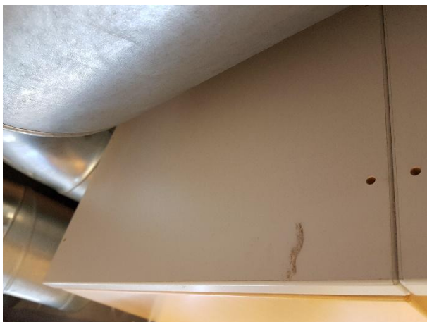
Kuva 25. Kaappien päällä havaittiin paikoin runsaasti yläpölyjä.
