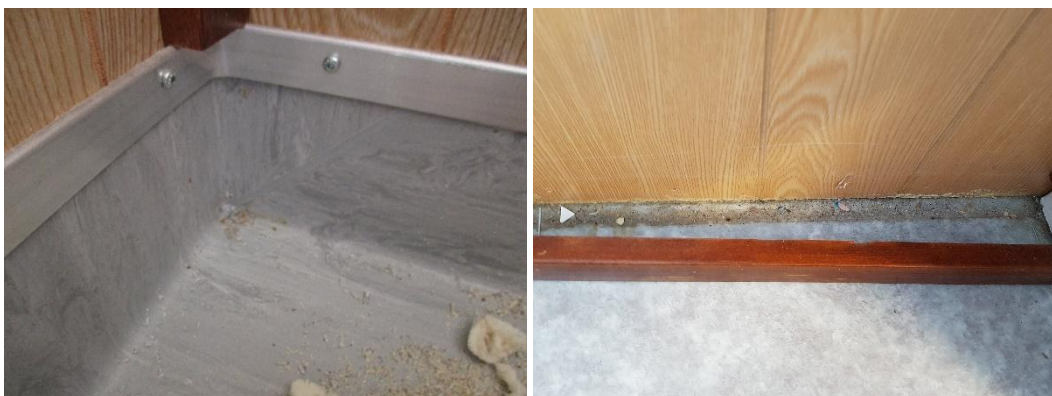
Kuvat 12 a ja b. Osassa moduuleja alapohjan muovimatto on nostettu ulkoseinälle (a) ja osassa on puinen jalkalista (b).
