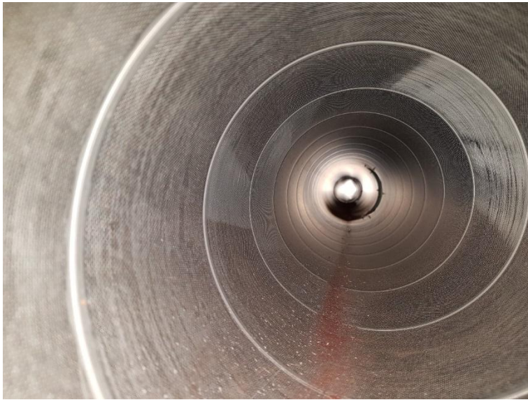
Kuva 20. Tuloilmaputkien pohjalla on punertavaa irtoainesta/ruostepölyä.
