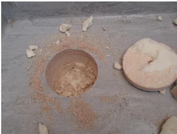
Kuva 7. Osassa moduuliyksiköiden alapohjissa on eristeenä polyuretaani.
