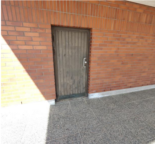
Kuva 50 Tekniseen tilaan johtavan metallirakenteisen oven pinta on puuverhoiltu.
