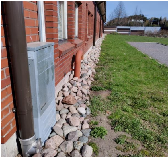
Kuva 7 Kuva rakennuksen itäisivulta. Piha-alue on nurmipeitteinen. Vierustalle on asennettu kivetys salaojaremontin yhteydessä. Maanpinta kallistaa loivasti pois päin rakennukselta.
