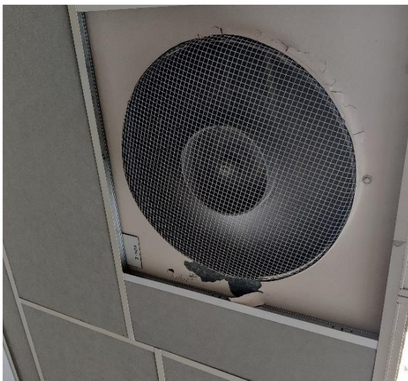
Kuva 72 Tuulikaappiin sijoitettu kiertoilmakone. KOK-2
