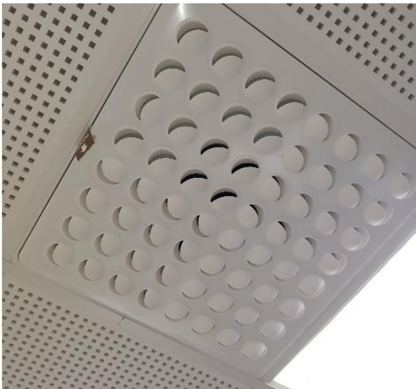
Kuva 83 Uusittu tuloilmahajotin.
