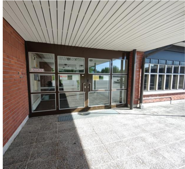
Kuva 51 Ulko-ovet ovat metallirakenteisia ja pääosin hyvässä kunnossa.
