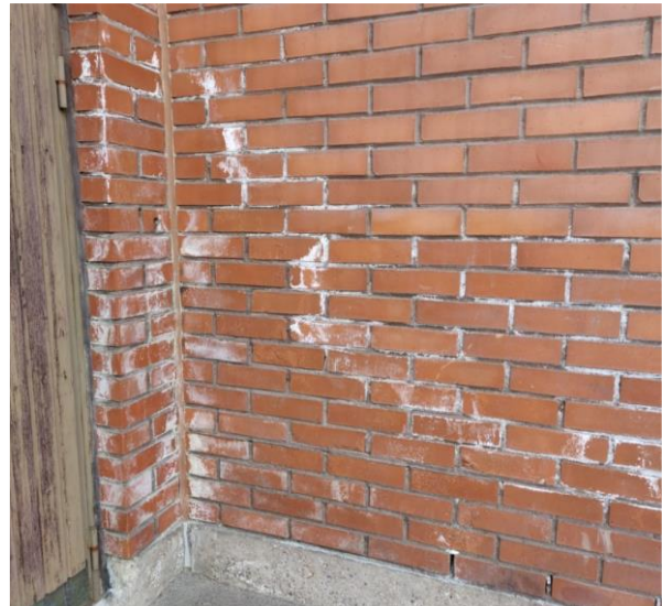
Kuva 37 Liikuntasalin länsisivustalla on voimakasta härmää julkisivuissa.
