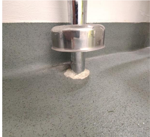
Kuva 61 Läpivienti on tiivistetty elastisella massalla.
