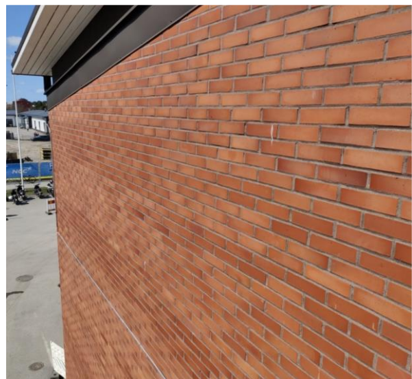
Kuva 39 Yleiskuva liikuntasalin eteläisivustan yläosasta.
