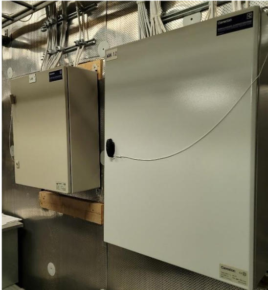
Kuva 85 Valvonta-alakeskuksia konehuoneessa.
