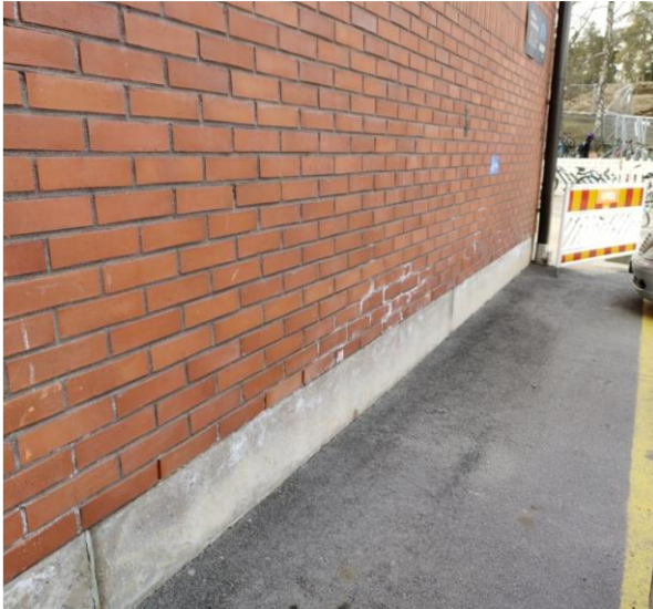
Kuva 5 Kuva rakennuksen länsisivustalta. Länsi- ja eteläisivustalla piha-alueet ja rakennuksen vierustat ovat asfaltoituja. Afalttipinta kallistaa loivasti pois päin rakennukselta.
