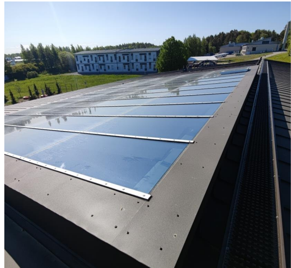
Kuva 55 Itäsiiven kattoikkunarakenne.
