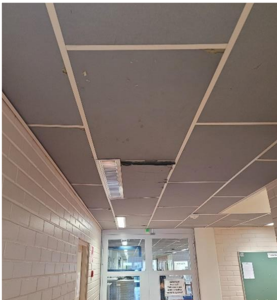
Kuva 104 Aulan alkuperäistä valaistusta.
