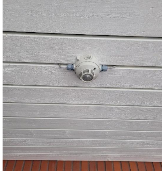
Kuva 111 Palovaroin katoksessa.
