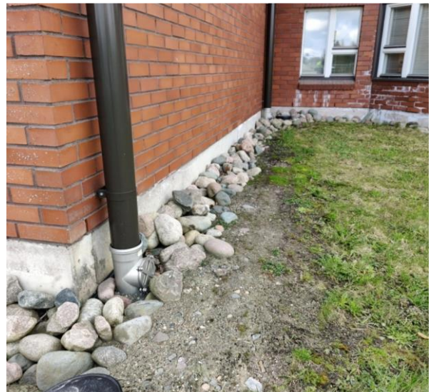
Kuva 4. Kuva rakennuksen pohjoissivulta. Sadevedet on ohjattu vesikatolta suoraan sadevesijärjestelmään.
