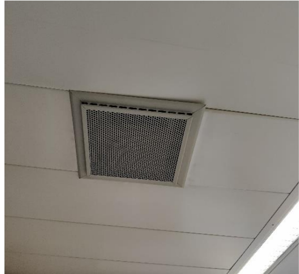
Kuva 82 Kattoon asetettu alkuperäinen tuloilmahajotin.
