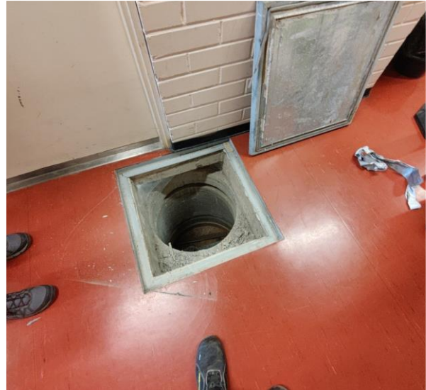
Kuva 29 Viemärin tarkastuskaivo liikuntasalin edustalla olevalla käytävällä. Kaivosta todettiin ilmavirtausta sisätilojen suuntaan.
