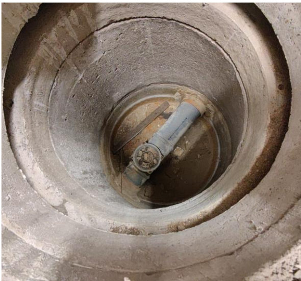
Kuva 30 Viemärin tarkastusluukku sijaitsee sisäpuolisen tarkastuskaivon kohdalla.
