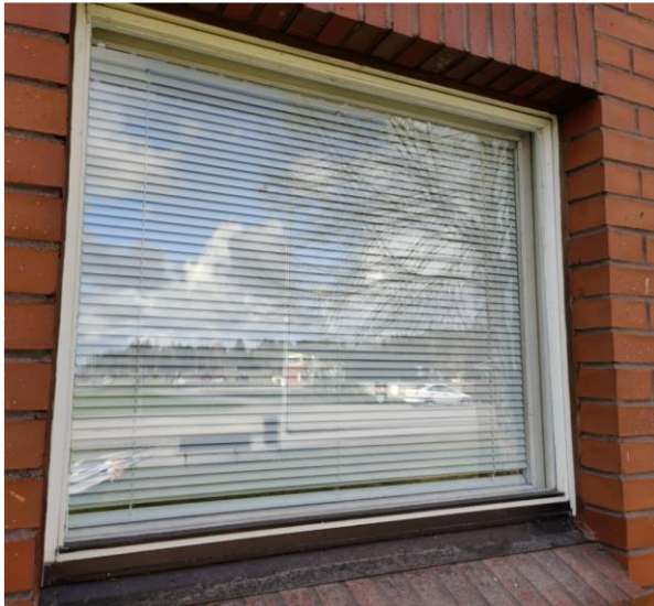
Kuva 42 Kuva kohteen puurakenteisesta ikkunasta.
