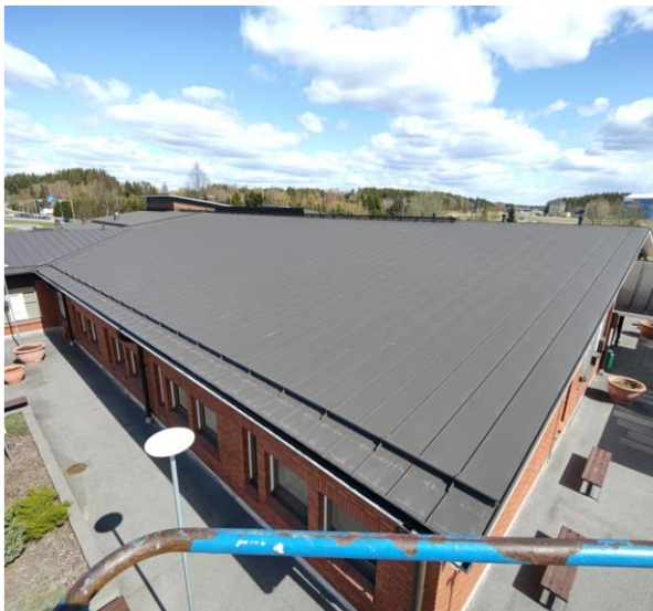
Kuva 52 Yleiskuva rakennuksen vesikatolta rakennuksen itäsiivessä.
