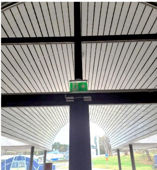
Kuva 105 Uusittu poistumisopastevalaisin.
