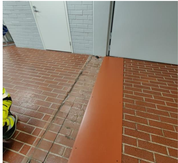
Kuva 21 Rakennuksessa on liikuntasauva itäsiiven ja pääaulan välissä.
