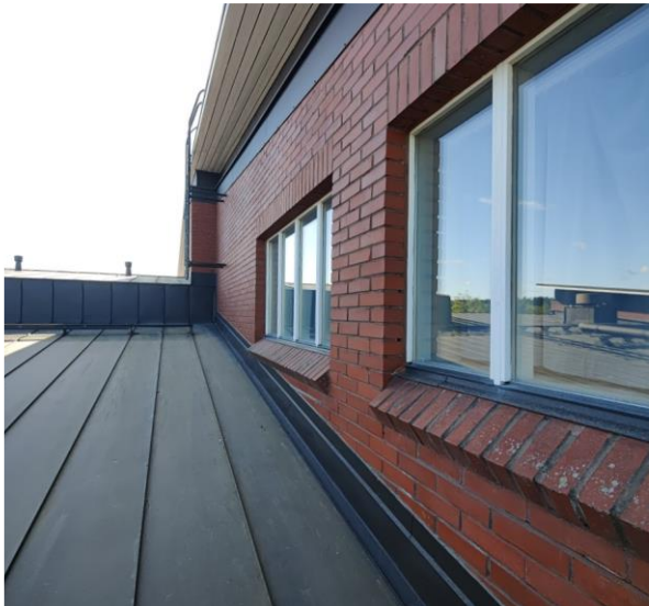
Kuva 54 Vesikate on nostettu ylösnostoksi liikuntasalin julkisivulle. Ylösnoston pellitys on uritettu ja tiivistetty tiilijulkisivuun.
