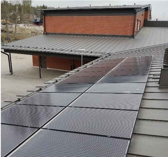
Kuva 95 Aurinkosähköpaneeleita vesikatolla.
