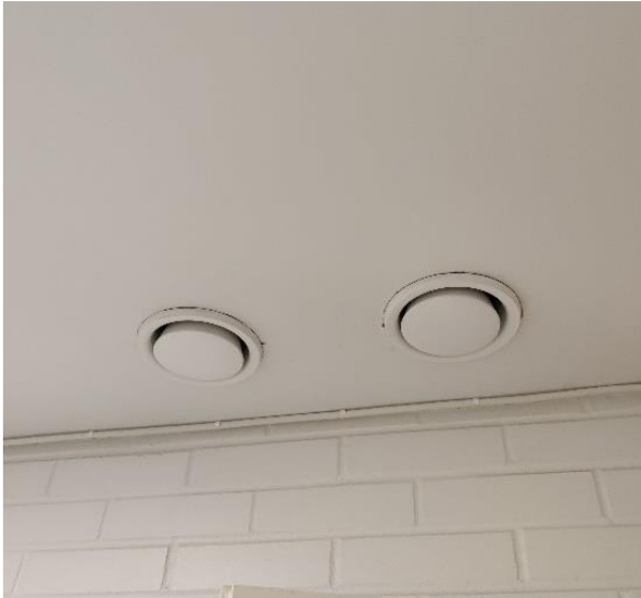
Kuva 81 Kartiomallinen poistoilmaventtiili.
