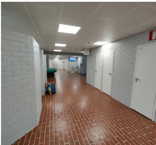
Kuva 58 Käytävien lattiapäällysteenä on tiililaatta. Itäsiiven alakattolevyt on uusittu vuonna 2022.
