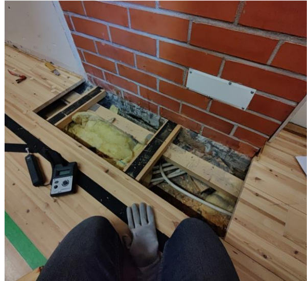
Kuva 25 Kuva rakenneavauksesta RA60.
