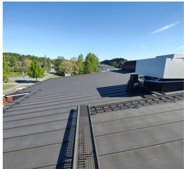
Kuva 53 Vesikate on konesaumattua peltiä. Pelti on tutkimusten perusteella hyvässä kunnossa.
