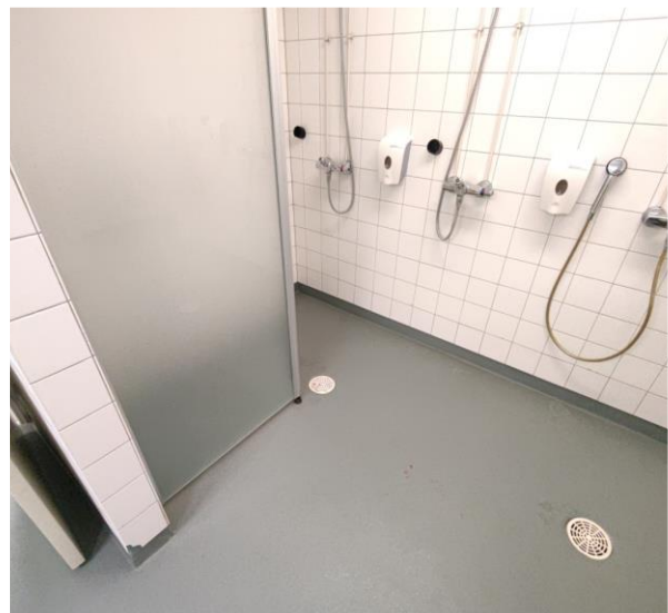
Kuva 59 Yleiskuva länsisiiven märkätilasta liikuntasalin pukuhuoneiden yhteydessä.
