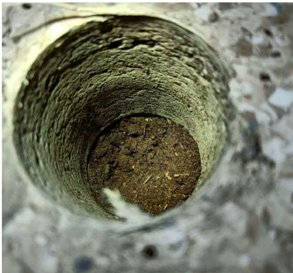
Kuva 74 Alkuperäisten 1950-luvulla rakennettujen rakennusosien välipohjarakenteissa on käytetty A1 osan luokkahuoneiden kohdalla sekä A2 osan 2. kerroksessa askeläänieristeenä turvetta.
