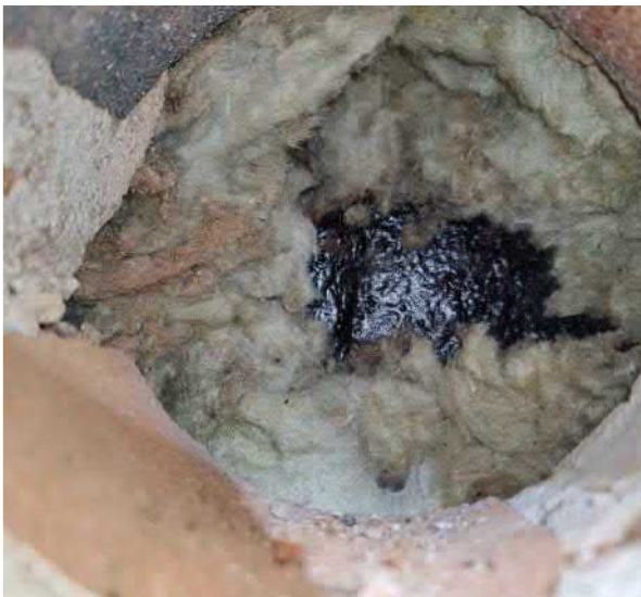
Kuva 34 Pääosa 1950-luvulla rakennetuista maanvastaisista seinärakenteista on vedeneristetty, lämmöneristetty ja tiiliverhoilu sisäpuolelta.
