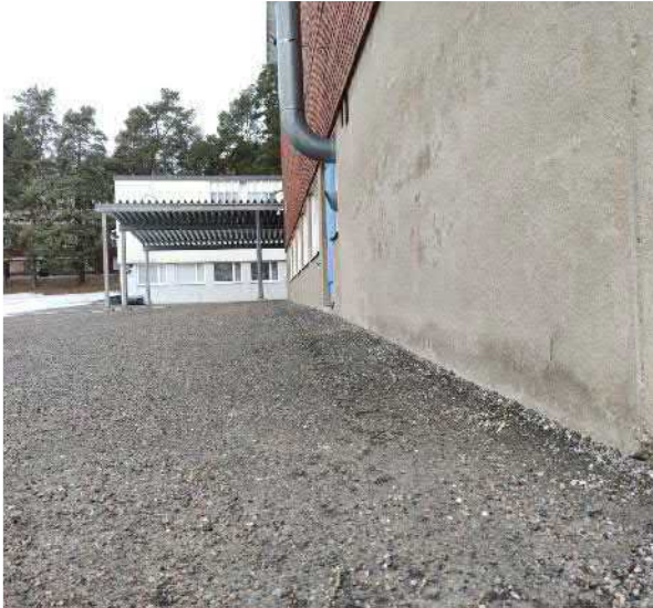
Kuva 7 Ala-aste A1 länsisivusta. Maanpinta kallistaa hieman poispäin rakennukselta.
