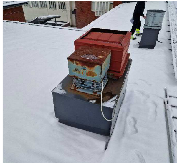
Kuva 170 Eri-ikäisiä erillispoistopuhaltimia.
