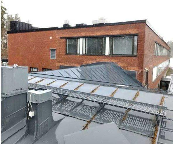
Kuva Yleiskuva rakennusosan D vesikattorakenteesta ja liitoksesta B-osalle.
