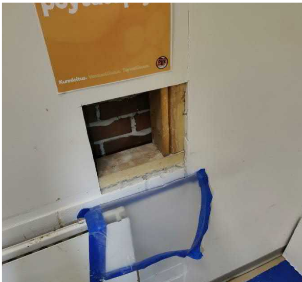
Kuva 83 Ruokasalin ja keittiön välissä on vanhan ulkoseinärakenne, josta on purettu suurin osa lämmöneristekerroksista.
