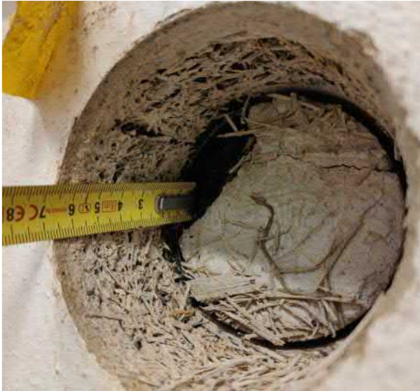
Kuva 32 Rakennusosan A2 käytävän maanvastaisten seinien patterisyvennyksen lämmöneristeenä on lastusementtilevyä
