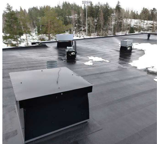
Kuva 105 Yleiskuva rakennusosan C vesikatolta.
