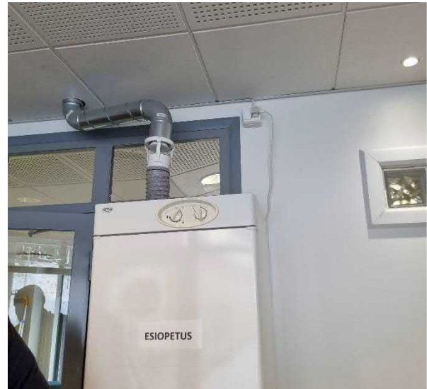
Kuva 176 A2-osalla kuivauskaappien poistokanavistoja on lisätty laitteille.
