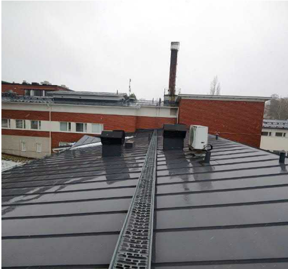
Kuva 94 Yleiskuva rakennusosan A2 vesikatolta. Peltikate on hyväkuntoinen.
