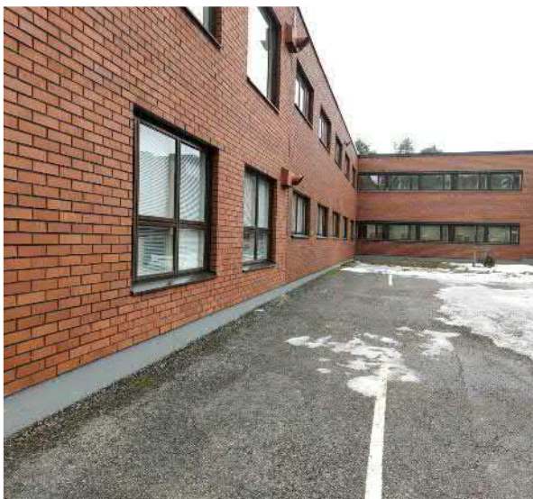
Kuva 17 Yläasteen osien C ja E2 länsisivusta. C-osalla sokkelin korkeus on matala, jopa alle 200mm.
