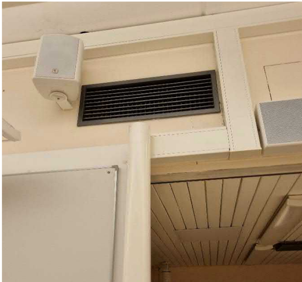
Kuva 197 Kotitalousluokan päätelaite.
