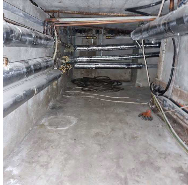
Kuva 115. Kanaalissa kulkevia putkistoja uusittu.
