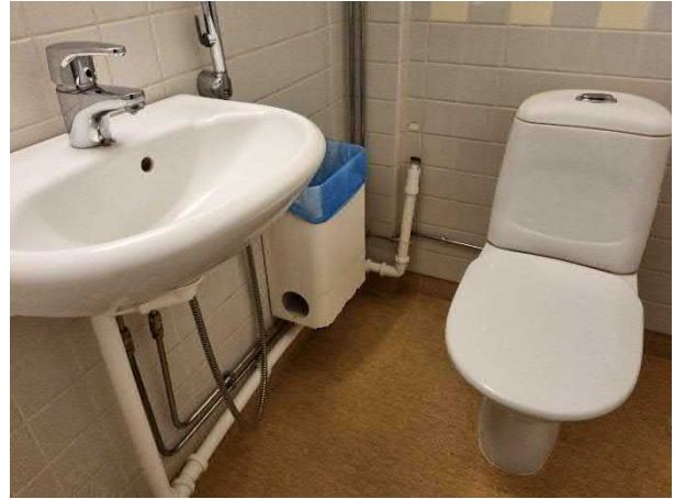
Kuva 127. Vesikalusteet ovat eri-ikäisiä. Paikoin vesikalusteita uusittu tarpeen mukaan.
