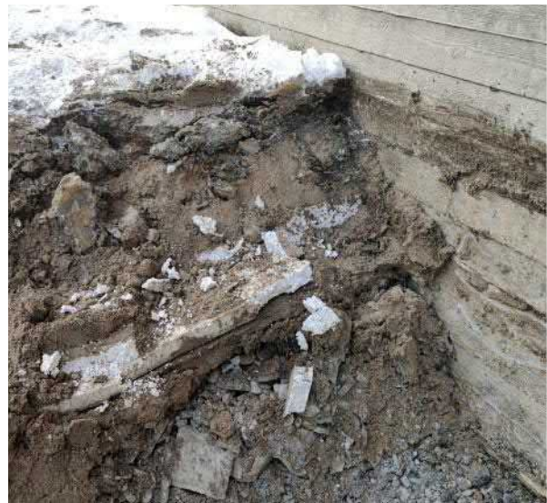
Kuva 28 1980-luvun rakennusosalla vierustoilla on routaeristykseenä n. 300mm syvyydessä maanpinnasta sijaitseva EPS-eristys.
