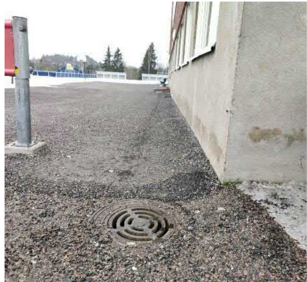
Kuva 4 Ala-asteen A1 eteläisivustalla maanpinta kallistaa loivasti pois päin rakennukselta. Sadevesikaivojen määrä on tarkasteluiden perusteella riittävä piha-alueella.
