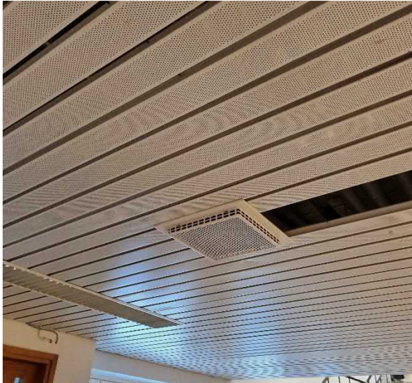
Kuva 179 114-käytävätilan tuloilmalaite.
