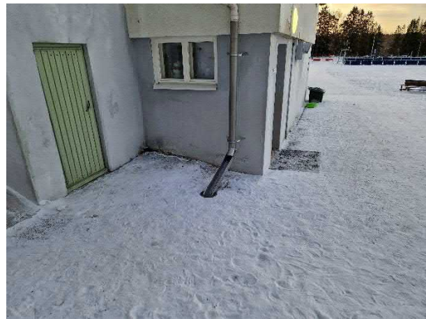
Kuva 140. Piha-alueen sadevesien ohjausta.
