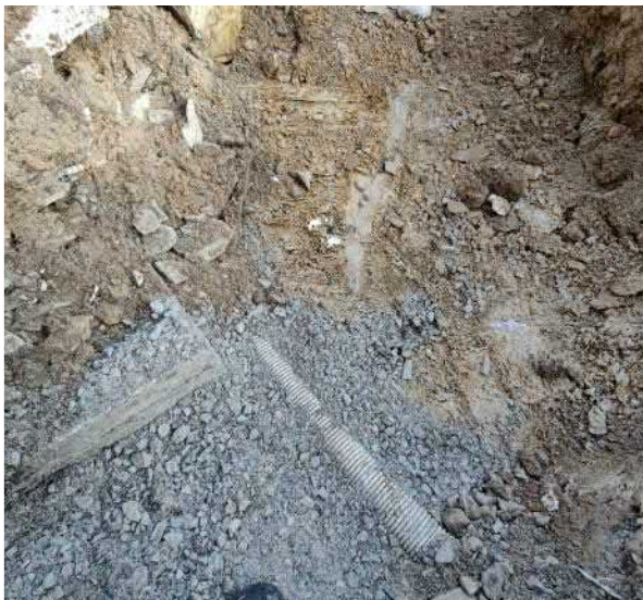
Kuva 27 Salaojitus sijaitsee anturan alapinnan yläpuolella. Salaojaputki on muovia.
