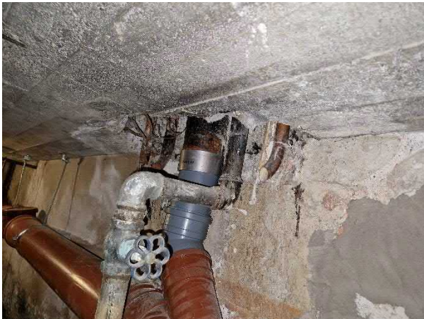
Kuva 131. Vanhemmalla osalla myös sukitettu vanhempia viemäreitä, joita liitetty muoviviemäriin.
