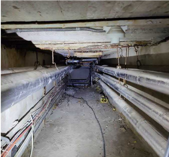
Kuva 52 Yleiskuva tekniikkakanaalista. Kanaaleissa ei todettu merkkejä kosteusrasituksesta. Yleisilme oli kanaaleissa pääosin siisti. Kanaaleissa havaittiin jonkun verran orgaanista materiaalia kuten muottilautoja.
