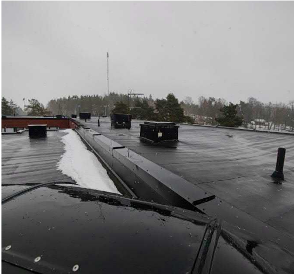
Kuva 100 Yleiskuva rakennusosan B-vesikatolta.
