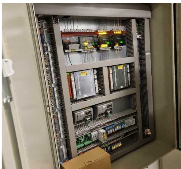
Kuva 209 IV-konehuoneen VAK4.
