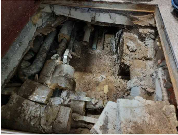
Kuva 114. Vanhempia lämmitysputkistoja kulkee lattiarakenteessa kanaalissa.
