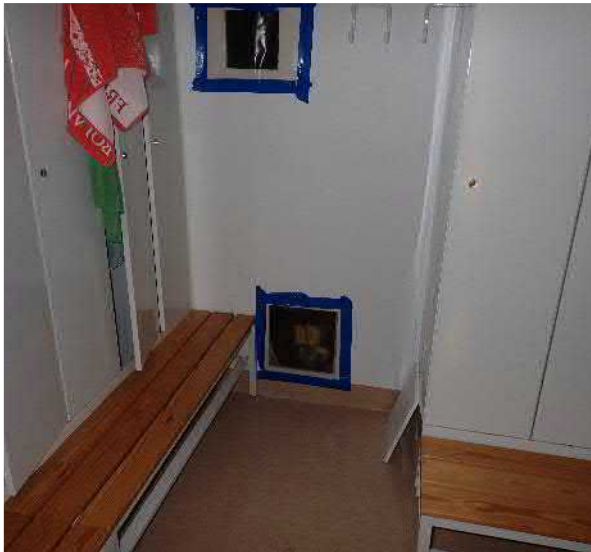
Kuva 44 Yläasteen pohjakerroksen lämmönjakuhuoneen vieressä sijaitsevan pukuhuoneen maanvastaiseen seinään tehtiin kaksi rakenneavausta.
