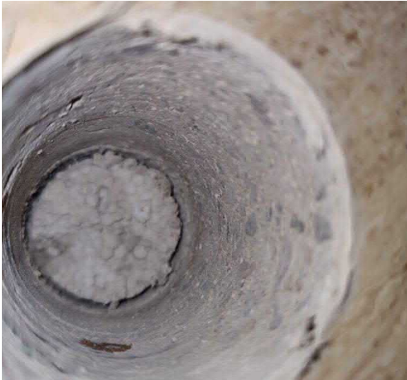
Kuva 77 Väestönsuojan kattorakenteen pinnassa on EPS-eriste ja betonilaatta.
