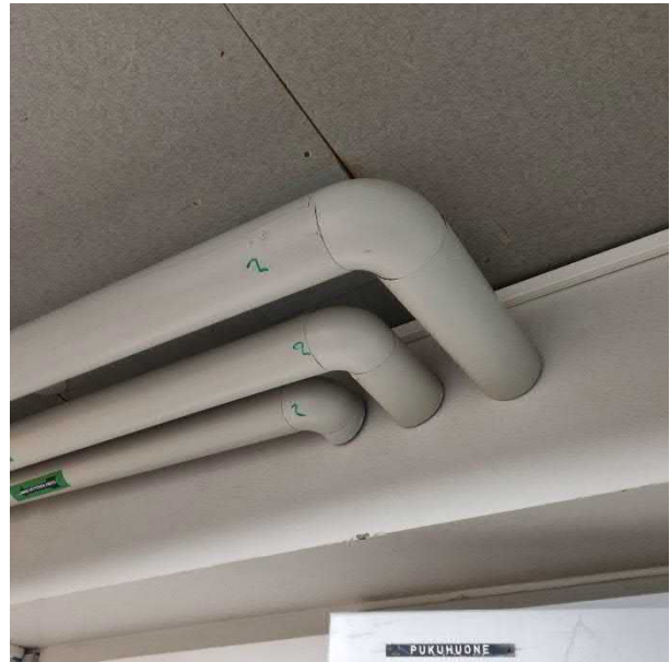
Kuva 121. Käyttövesiputket on eristetty mineraalivilloin ja päällystetty näkyvillä osin pvc-pinnoittein.
