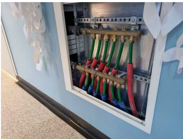
Kuva 124. Uusimmalla osalla käyttövesijohtoja toteutettu myös muoviputkin suojaputkissa.
