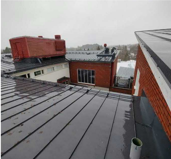
Kuva 88 Yleiskuva rakennusosan A1 vesikatolta.
