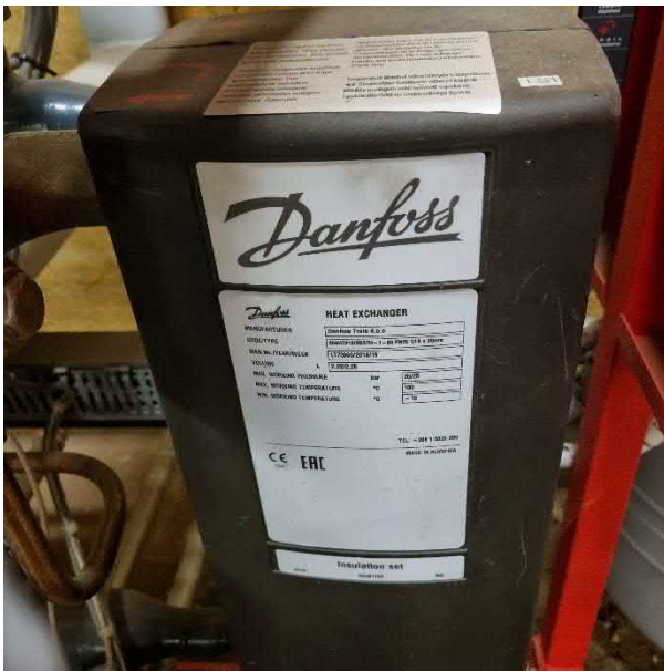
Kuva 120. Käyttövesiverkoston siirrin
