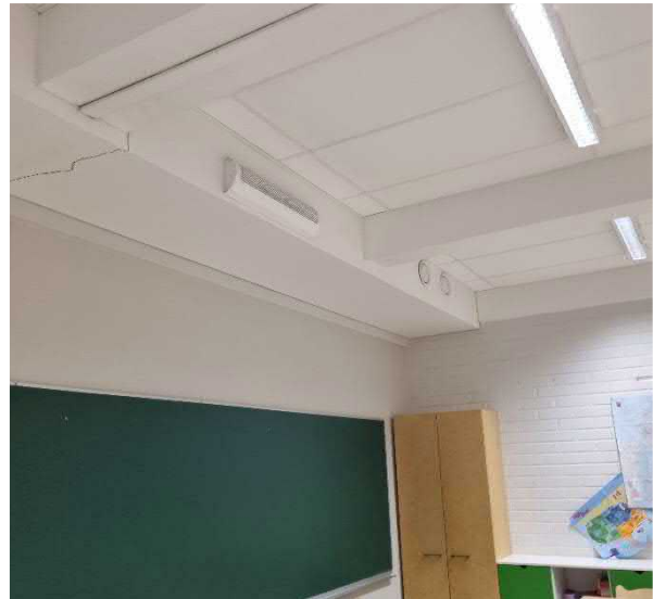
Kuva 202 B-osan 2.kerrosen luokkatilojen ilmanvaihtoventtiilit ovat seinämällisiä.
