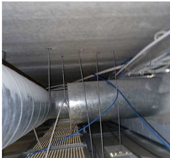
Kuva 186 C-osan 1.kerrosn käytävän alakatosta otettu kuva. Kuvassa oikealle lähtevissä kanavahaaroissa on vanhoja äänenvaimenninosia. Nämä vanhat osat saattavat sisältää mineraalivillakuitulähteitä.
