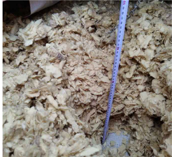
Kuva 89 Yläpohjan kantavana rakenteena on betonilaatta. Eristeenä on mineraalivilla.
