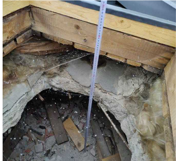
Kuva 95 Esikoulutilojen yläpohjarakenne on pääosin alkuperäinen ja koostuu useasta eri kerroksesta.
