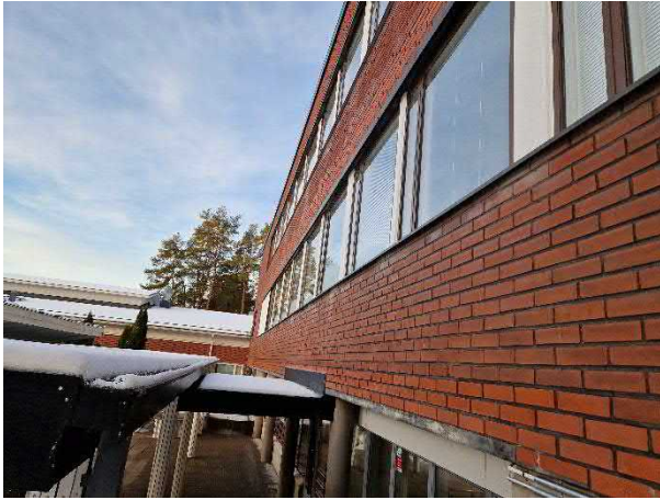
Kuva 141. Piha-alueen ja kattosadevesien ohjausta.
