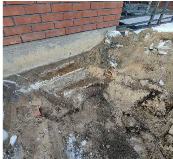
Kuva 26 1980-luvun C-osan itäisivustalle kaivetun koekuopan kautta havaittiin täyttöaineskerroksen olevan hienojakoista.
