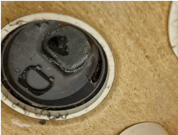
Kuva 137. Uusittu lattiakaivo
