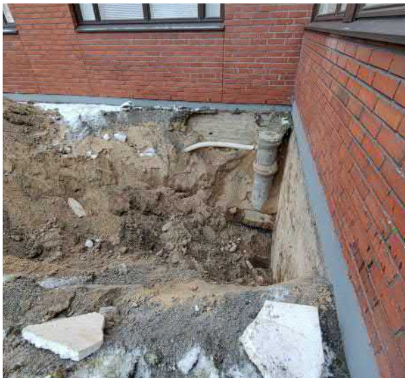
Kuva 23 Yläasteen B ja C liitoskohtaan tehty koekuoppa.
