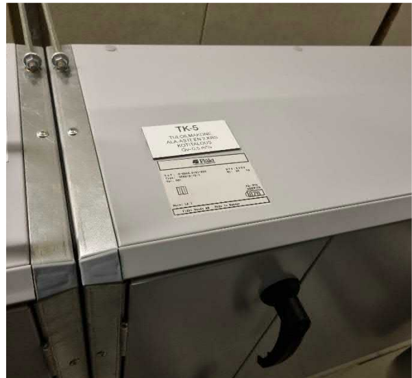
Kuva 161 Tulokone TK5 on kattoasenteinen kompaktimalin tulokone.
