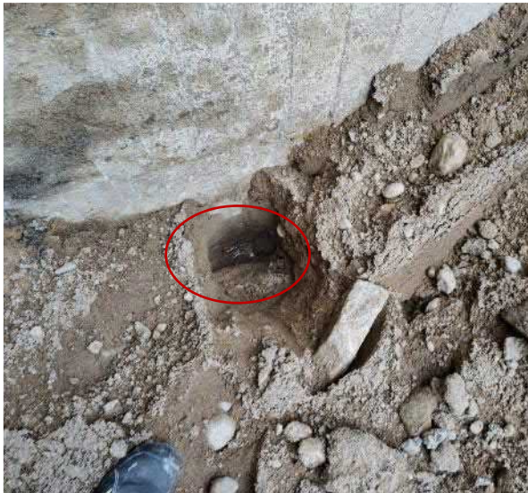
Kuva 25 Koekuoppaa ei saatu kaivettua 1970-luvun rakennusosalla perustustasoon saakka. Kuopan pohjalle kerääntyi vettä.
