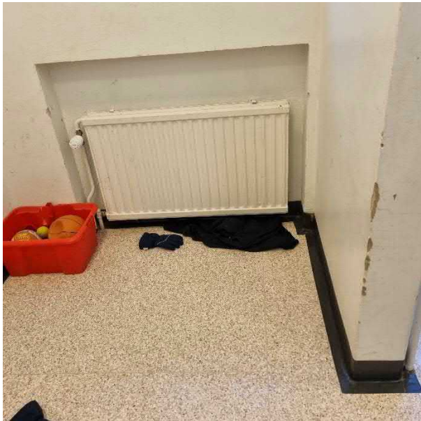
Kuva 118. Patteriventtiilit ja termostaattiosat uusittu
