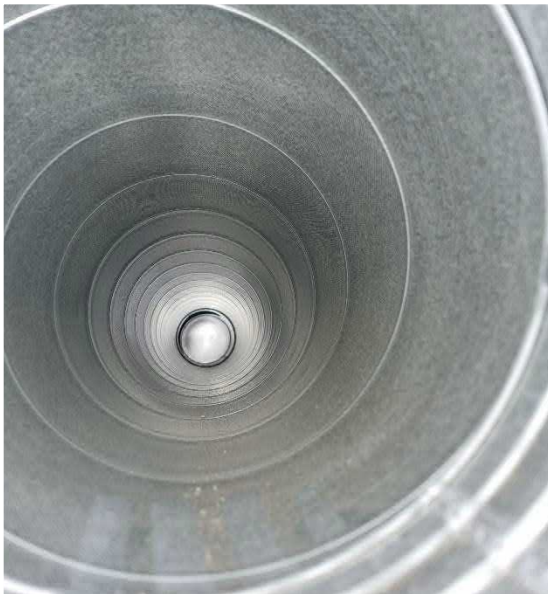
Kuva 177 Luokan 140 tulokanavisto oli aistinvaraisesti tarkastellen melko puhdas.
