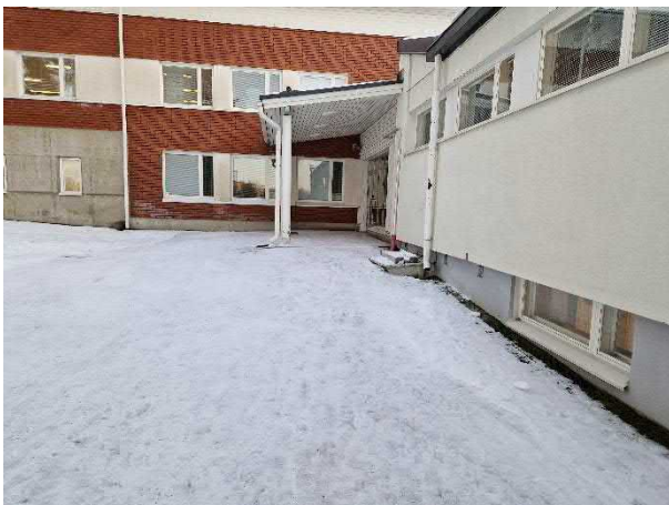
Kuva 139. Piha-alueen sadevesien ohjausta.
