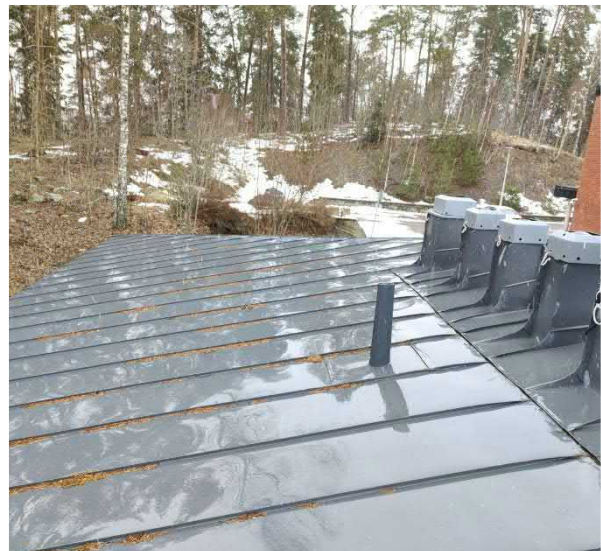
Kuva 174 Alemman vesikaton erillispoistoja.
