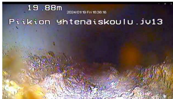
Kuva 9. Padottavaa likaa.
