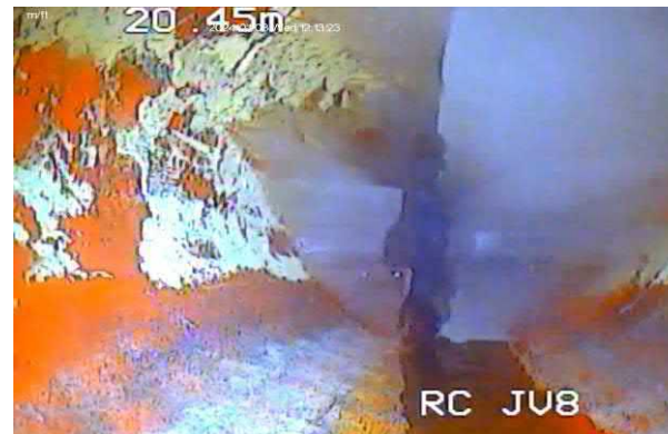
Kuva 10. Sadevesiputki jäätynyt
