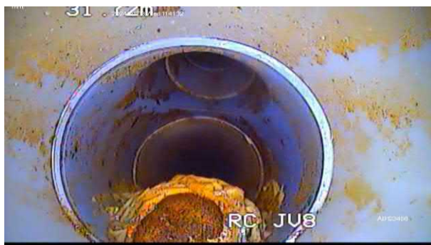
Kuva 5. Padottavaa likaa.
