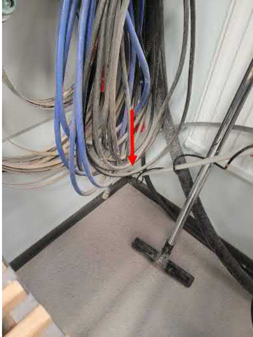
Kuva 22 Alapohjan nurkkaliitos vuotaa vähäisesti.
