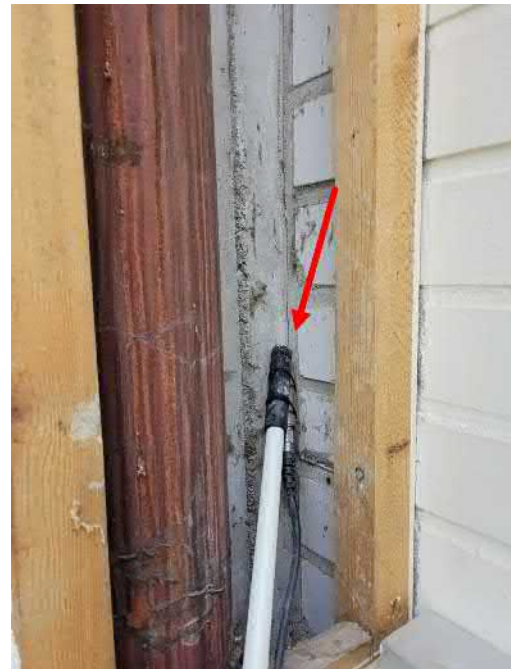
Kuva 41 Vanha US ny. VS ja muurattu väliseinän liittymän lähikuva
