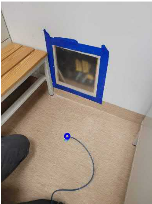
Kuva 24 Merkkiainekokeen syöttöpiste alapohjaan
