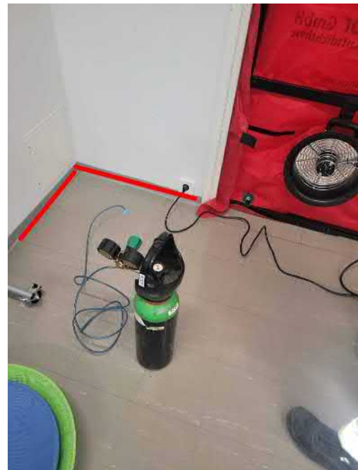
Kuva 33 Alapohja-ulkoseinä liittymä vuotaa merkittävästi
