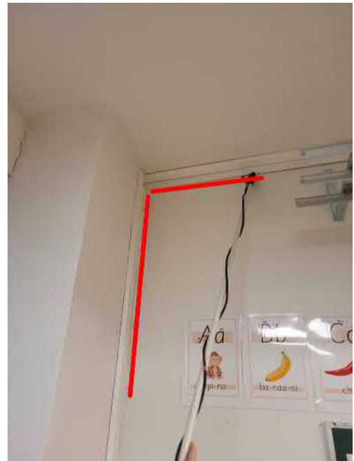
Kuva 4 Sähkökouru nurkka ja läpivienti vuotaa vähäisesti.
