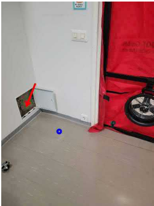
Kuva 32 Merkkiainekokeen syöttöpiste alapohjaan, tarkistus luukun sisältä vuotaa
