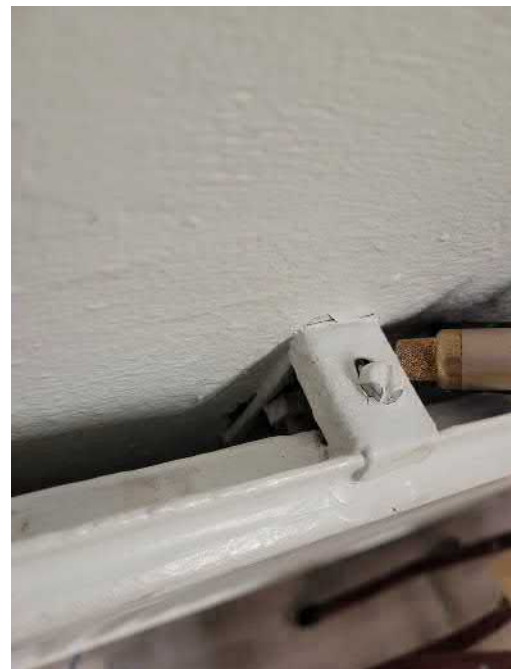
Kuva 13 Patterin kannakkeet vuotavat pistemäisesti
