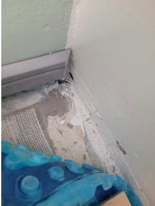
Kuva 62 Nurkan tiivistykset repsottavat
