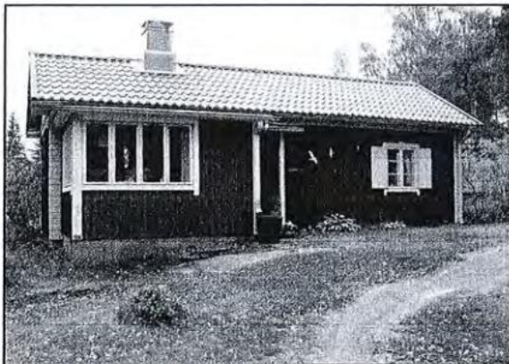
päärakennus (rakennus 1) koilliseen
