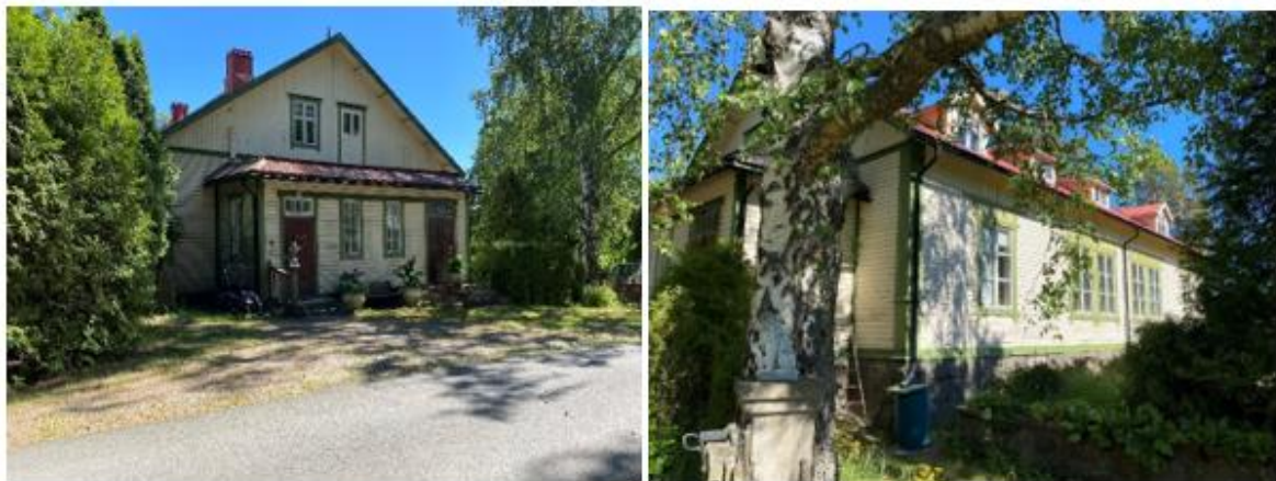
Kuva 29: Torppalan tilan päärakennus Torppalantieltä päin kuvattuna sekä julkisivu merelle päin. (FCG, 2022)
