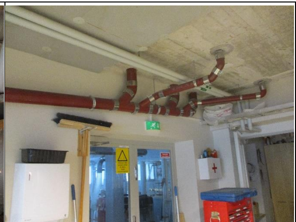
Uusittuja viemärointejä teknisessä luokassa
