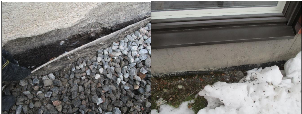
Ala- ja yläasteen (A1, B) kermi- ja bitumieristys
