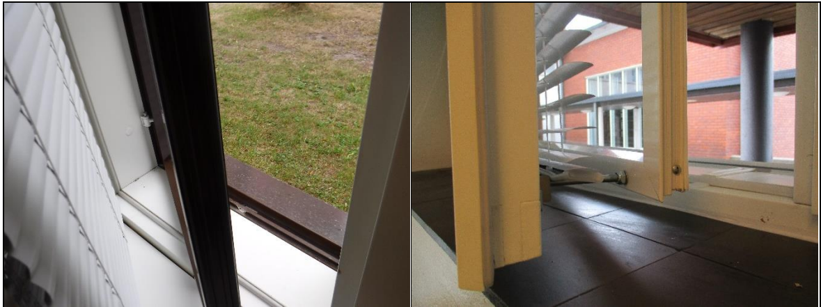
Ikkunat on uusittu koko koulussa
