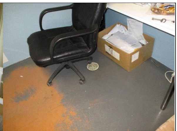
Kiinteistöhoitajien yläasteen (B) sosiaalitilojen kellarikerroksen lattia
