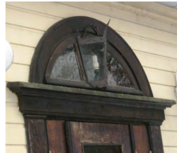
Ulko-oven päällä oleva lanterni.
