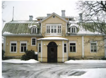
Julkisivu pohjoiseen, pääsisäänkäynti.
