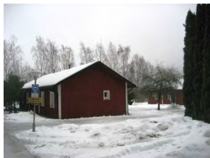
Puukujanteen viereinen vaja- ja varastorakennus.
