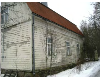
Puukujanteen puoleinen julkisivu.
