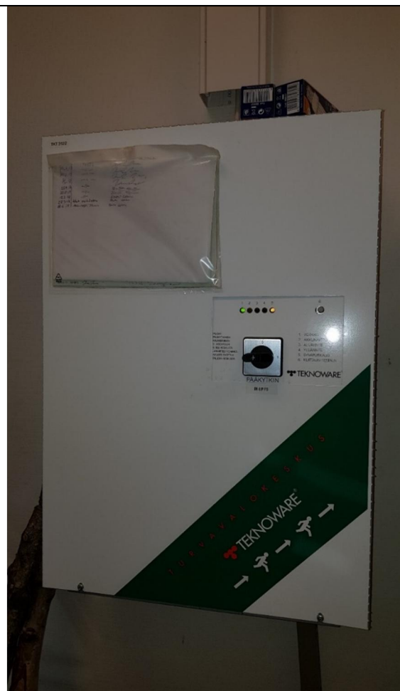
Puurakennuksen turvalokeskus, jossa syväpurkaushälytys.
