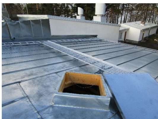
Kivikoulun uusittua vesikatetta.
