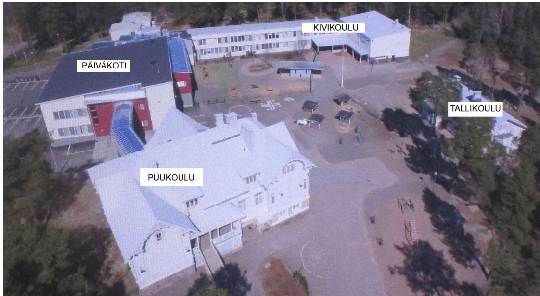
Kuvassa Lastentalon rakennukset. Päiväkoti on uudisosa.
