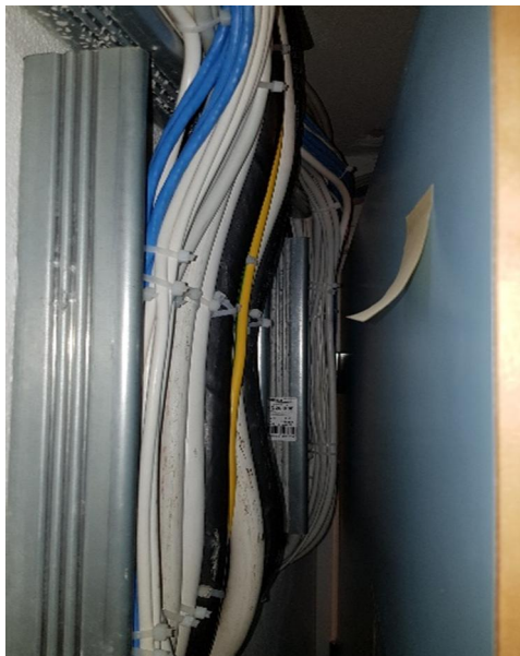
Kaapelihyllyasennuksia teknisessä tilassa.
