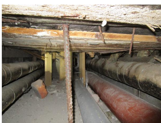
Kivikoulun alapohjan putkikanaalissa on Kanaaliin on käyntiluukku varastotilasta.
