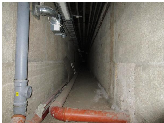
Kivikoulussa luokkatilojen alla oleva putkikanaali.
