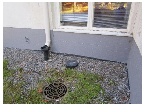
Kivikoulun voimistelusiipeen on asennettu patolevytys ja sorakaistale.
