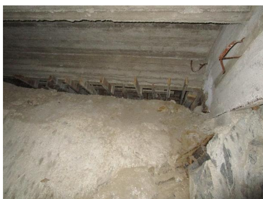
Kivikoulun ryömintätilassa on vanhoja muottilautoja.
