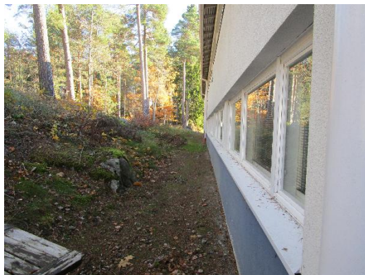
Kivikoulun pohjoissivulla maanpinta laskee kohti rakennusta.
