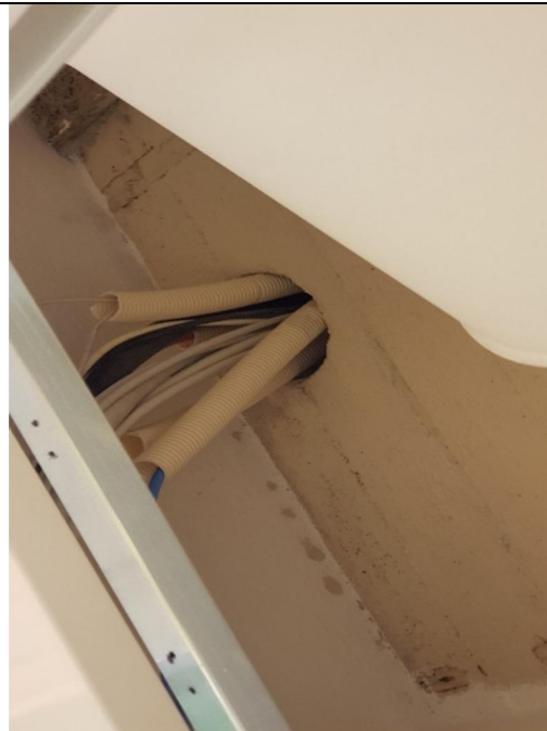
Kerrosten välinen läpivienti.
