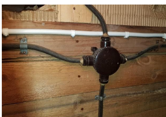
Vanhat asennukset ullakolla.
