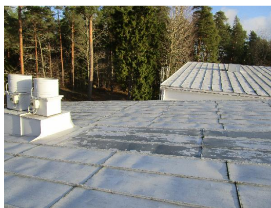
Ja katteen pinnoite hilseilee.
