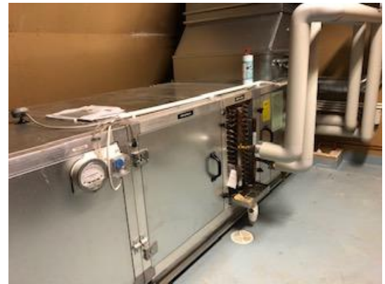
Puukoulun poistoilmanvaihtokoje.
