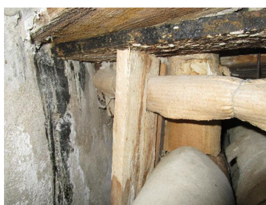
kosteusvaurioitunutta rakennusmateriaalia.
