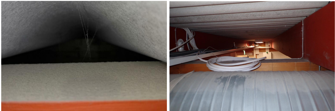
Kuvat 8 ja 9. Yhtenäisenä jatkuvien levyjen kohdilla yläpölyjen koostumus oli hienojakoisempaa. Yläpölyjä oli erittäin runsaasti myös kaikilla muilla yläpinnoilla.
