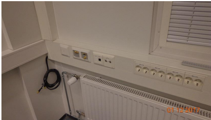
Yleiskaapelointi- ja antennijärjestelmä ovat hyvässä kunnossa.
