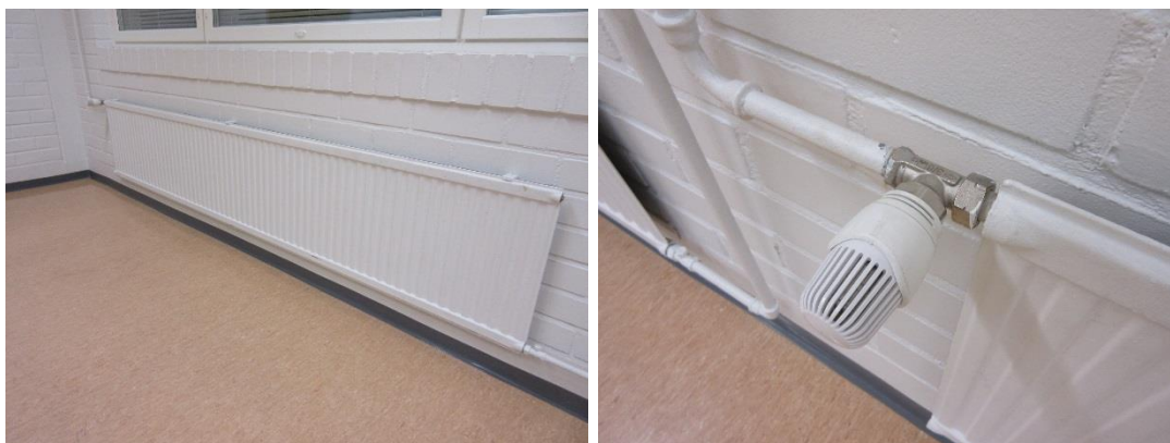
Alkuperäinen lämmityspatteri ja Oras Oy:n patteriventtiili.
