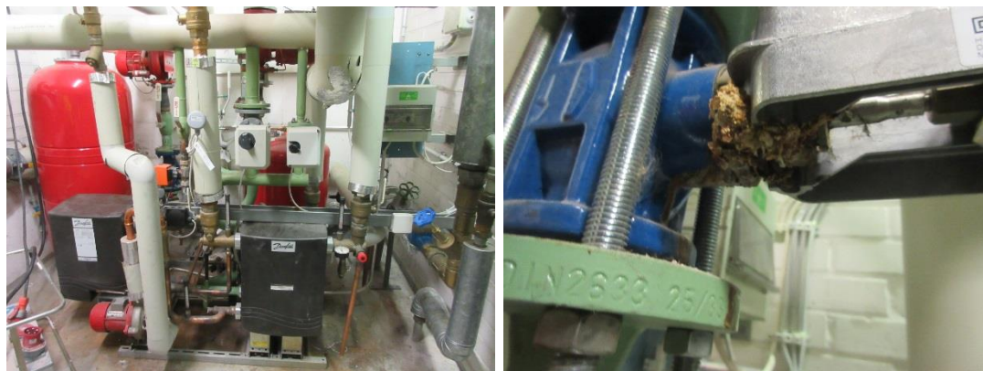
Alajakokeskus lämmönjakohuoneessa sekä vuotojälkiä moottoriventtiilissä.
