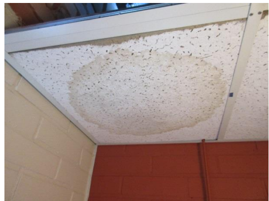
Puutteellinen kanavaläpivienni käytävän WC- tilassa, josta on vuotanut vettä alakattolevyyn.
