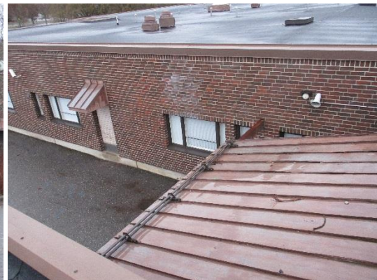
Tiiliverhouksen yläosa, korjaamaton osuus
