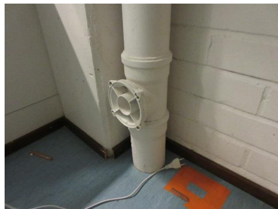
Saneerattu WC- tila sekä muovinen jäteveden puhdistusluukku.
