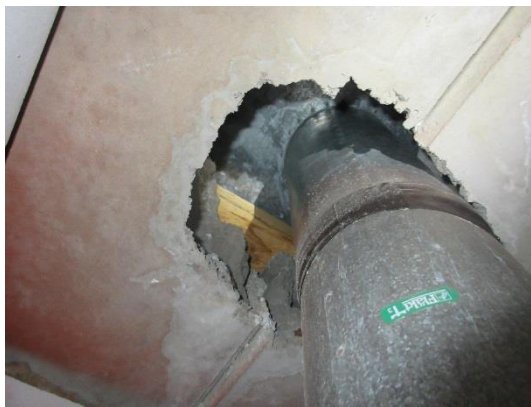
Puutteellinen kanavaläpivienni käytävän WC- tilassa, josta on vuotanut vettä alakattolevyyn.
