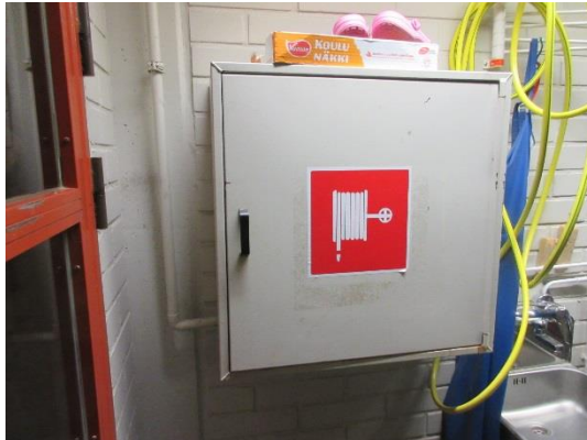
Paloposti sekä uusittuja käyttövesijohtoja (komposiitti) luokkatilassa.
