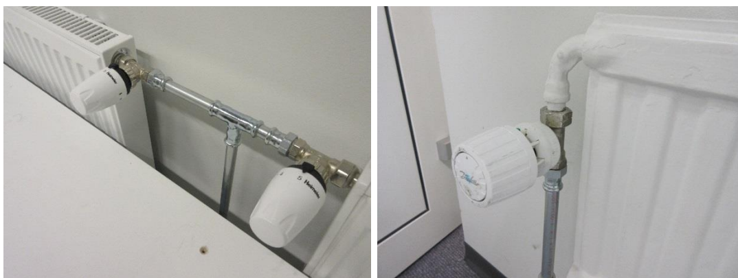
Eri valmistajien patteriventtiilejä.
