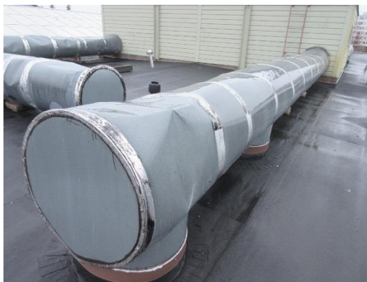
Runkokanavistoa vesikatolla ja alakattorakenteessa sekä alumiinisia kytkentäkanavia.
