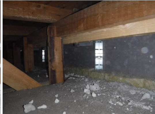
Yläpohjan ja ulkuvuorauksen liittymäkohta. Oikealla korjatun julkisivun ja yläpohjan liittymäkohta
