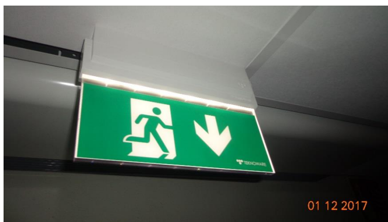
Turvavalojärjestelmässä on vanhoja sekä uusia poistumisvaloja.
