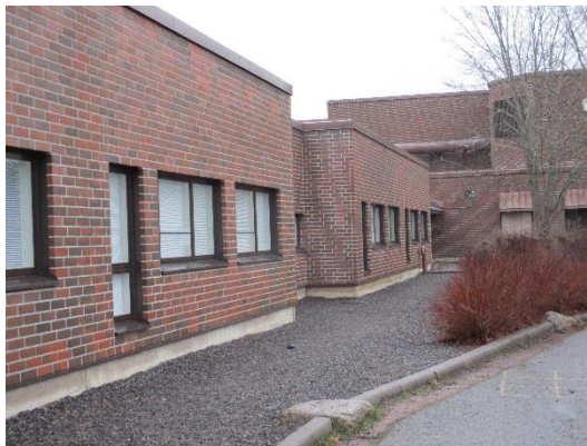
Korjattu julkisivun osa
