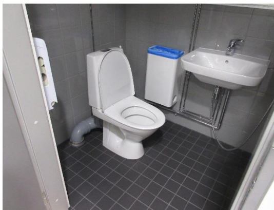
Saneerattu WC- tila sekä muovinen jäteveden puhdistusluukku.
