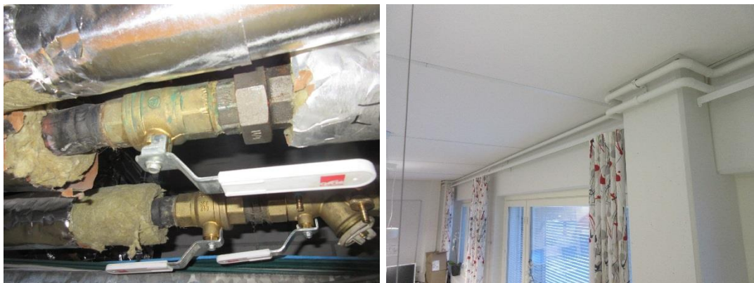
Runkoputkiston sulku- ja linjasäätöventtiilejä sekä näkyvillä olevia alkuperäisiä kytkentäputkia.
