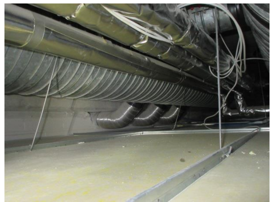
Runkokanavistoa vesikatolla ja alakattorakenteessa sekä alumiinisia kytkentäkanavia.
