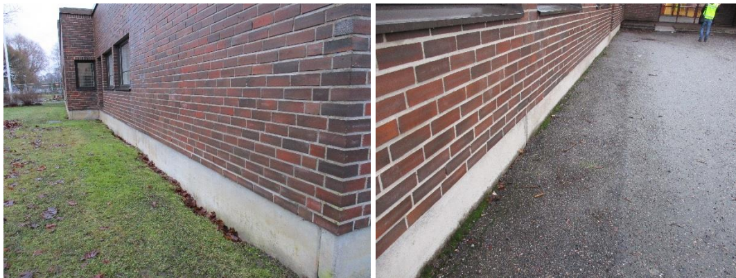
Ulkoseinien vierustäytöissä on havaittavissa painumaa
