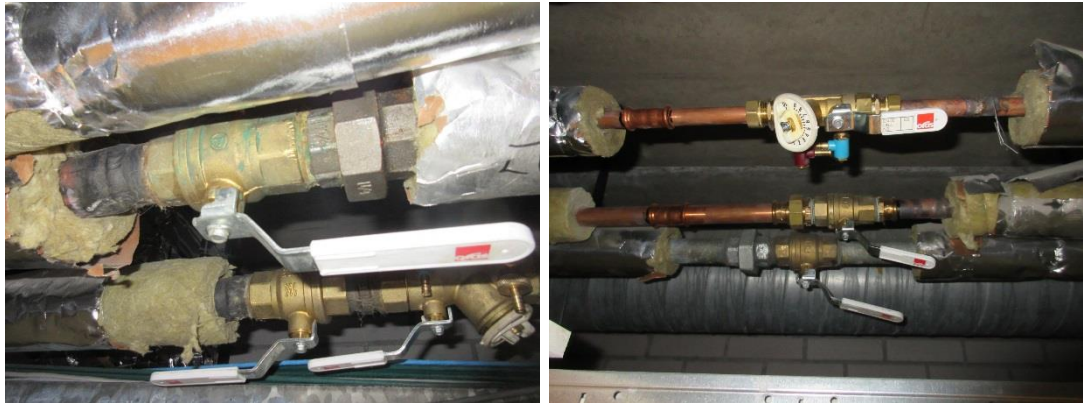
Rikkoutuneita/ puutteellisia eristyskohtia alakattorakenteessa käytävällä.
