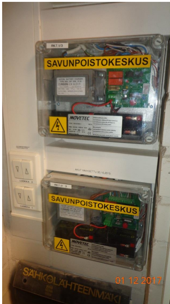
Savunpoistojärjestelmä on tyydyttävässä kunnossa.
