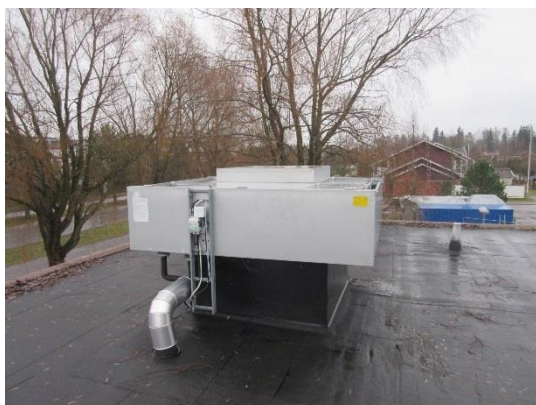
Keittiötä palveleva lämmöntalteenottosiirrin sekä alkuperäinen huippumuri.
