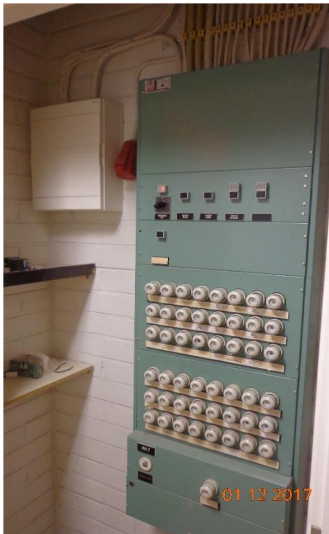
Alkuperäinen jakokeskus, johon lisätty saneerauksen yhteydessä uusi ryhmäkeskus.
