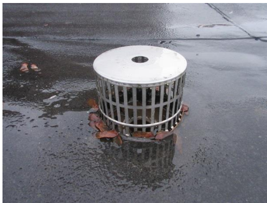
Saneerattu kattovesikaivo sekä salaojakaivo, jossa on sinne kuulumatonta tavaraa.
