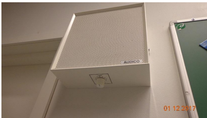
Äänentoisto/kuulutusjärjestelmä on tyydyttävässä kunnossa.
