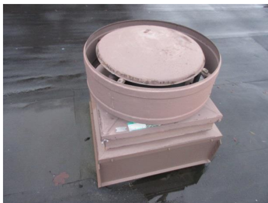
Keittiötä palveleva lämmöntalteenottosiirrin sekä alkuperäinen huippumuri.
