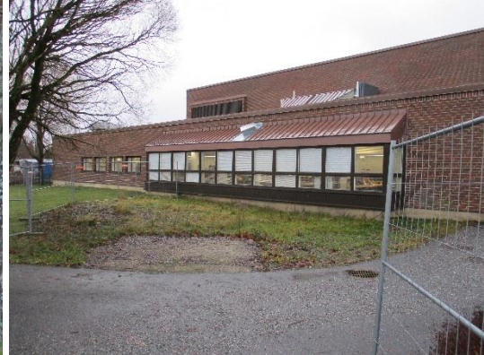
Ruokasalin korjattu erkkerirakenne
