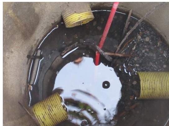
Saneerattu kattovesikaivo sekä salaojakaivo, jossa on sinne kuulumatonta tavaraa.
