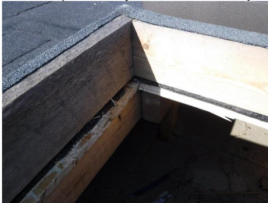
Kattopalkisto ja rakenteet ovat hyväkuntoisia
