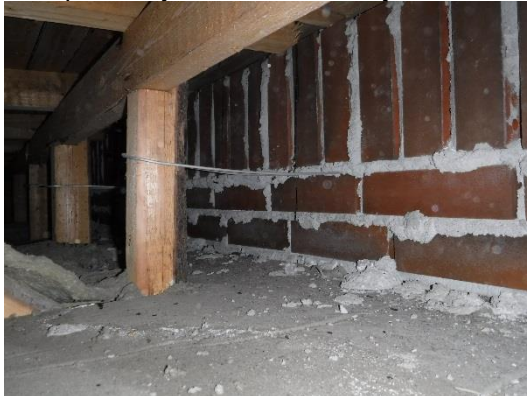
Yläpohjan ja ulkuvuorauksen liittymäkohta. Oikealla korjatun julkisivun ja yläpohjan liittymäkohta
