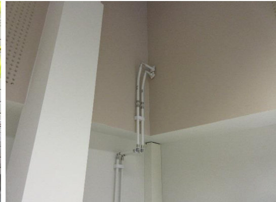
Paloposti sekä uusittuja käyttövesijohtoja (komposiitti) luokkatilassa.
