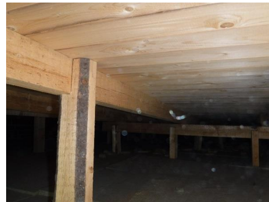
Vesikatteen alapuoliset rakenteet ovat hyvässä kunnossa, kuvat aiemmista raporteista
