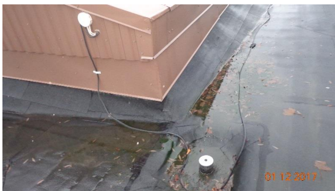
Sadejärjestelmien sulanapitojärjestelmä.
