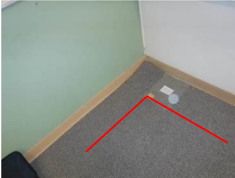
Kuva 3. Lattiapäällystettä poistetaan ryhmätilassa 125 yhden tekstiililaatan matkalta.
