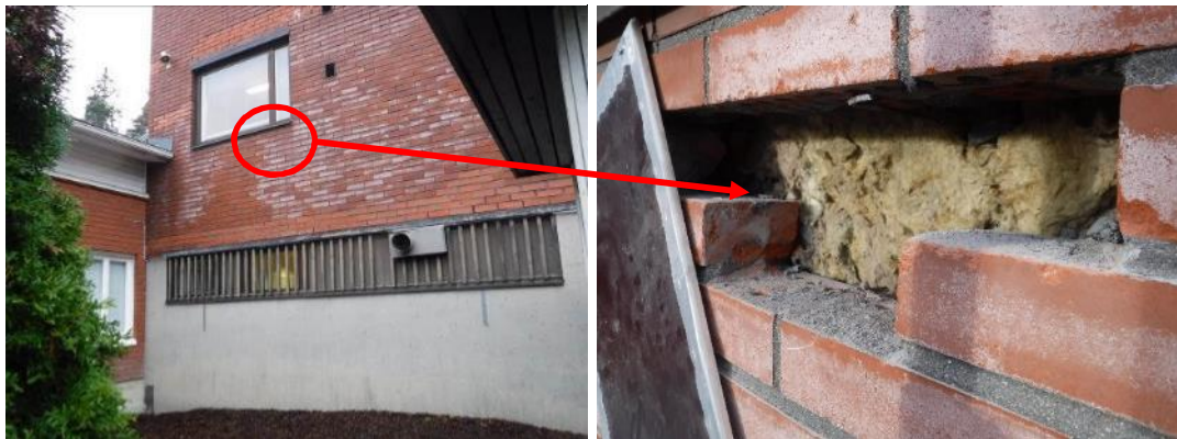
Kuvat 6 ja 7. Rakenneavaus nro 3.
