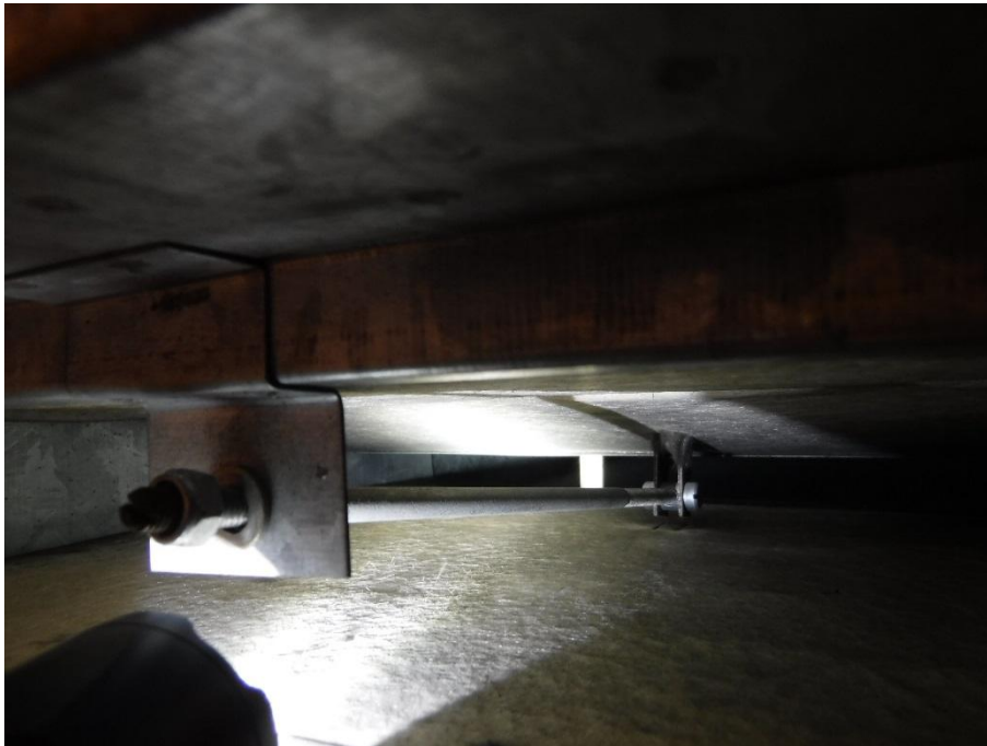
Kuva 24. Tuloilmapäätelaitteen sisällä näkyy mineraalivillaa.
