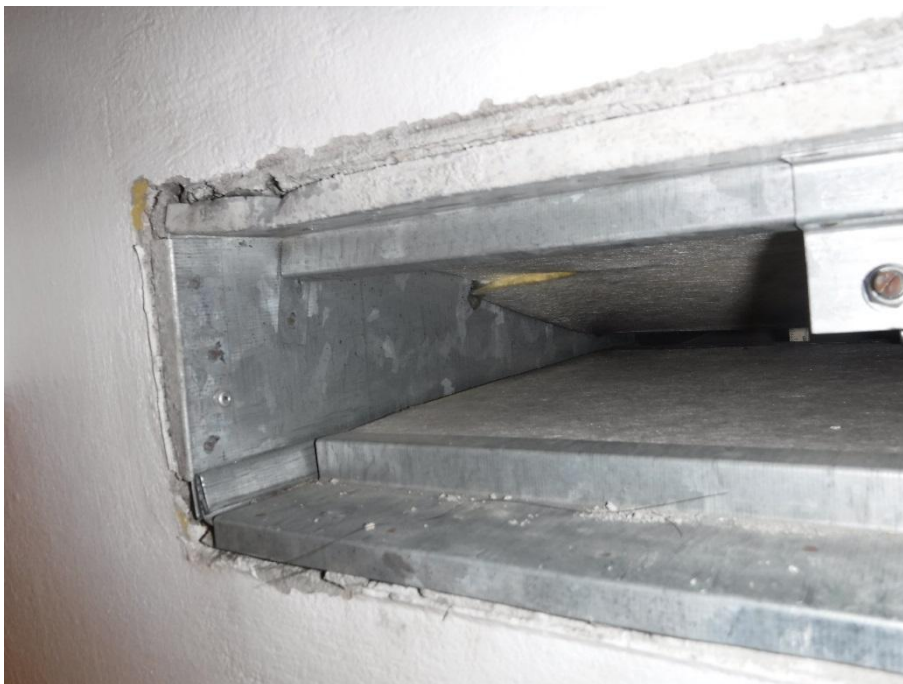
Kuva 23. Tuloilman päätelaite, jonka ritilä on poistettu paikoiltaan.
