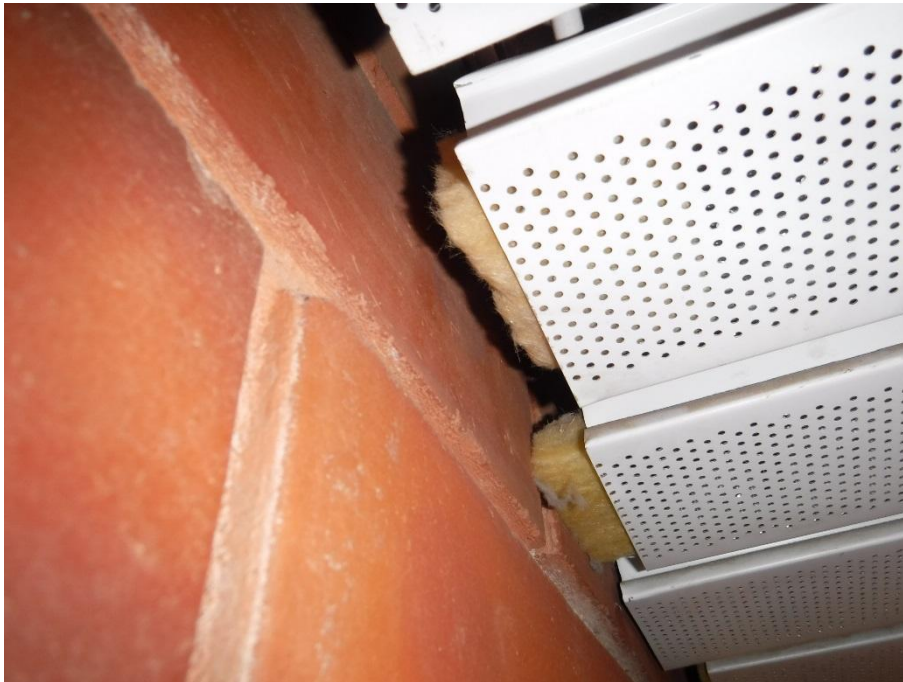
Kuva 26. Metalliritilöiden sisällä on pinnoittamatonta mineraalivillaa.
