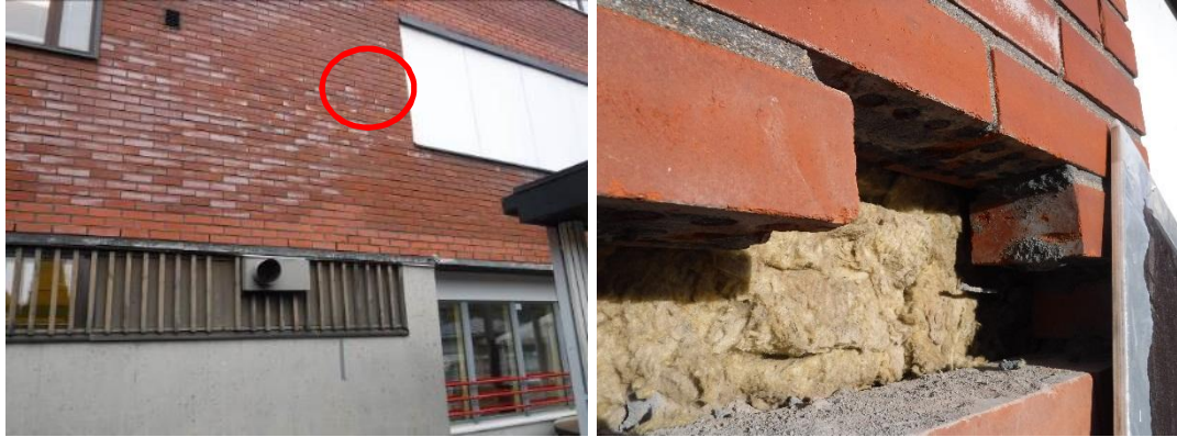
Kuvat 4 ja 5. Rakenneavaus nro 2.
