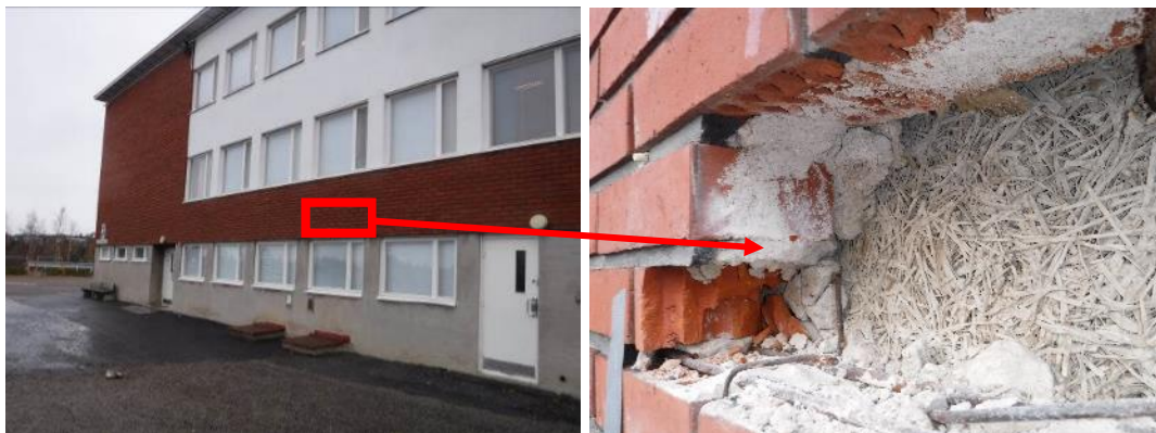
Kuvat 15 ja 16. Rakenneavaus nro 8.
