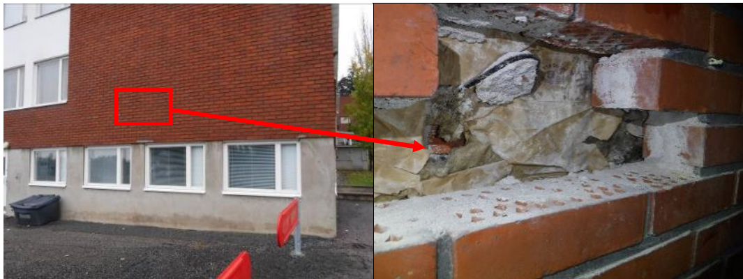
Kuva 13 ja 14. Rakenneavaus nro 7.
