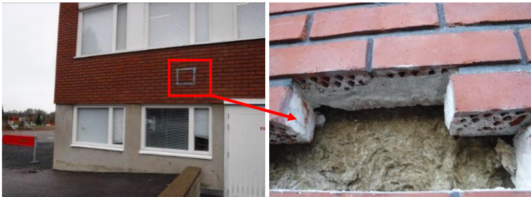
Kuva 11 ja 12. Rakenneavaus nro 6.
