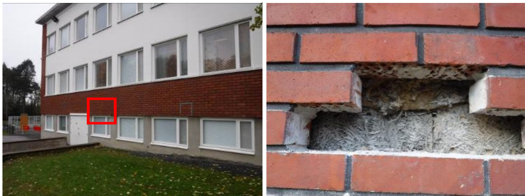
Kuvat 8 ja 9. Rakenneavaus nro 5.
