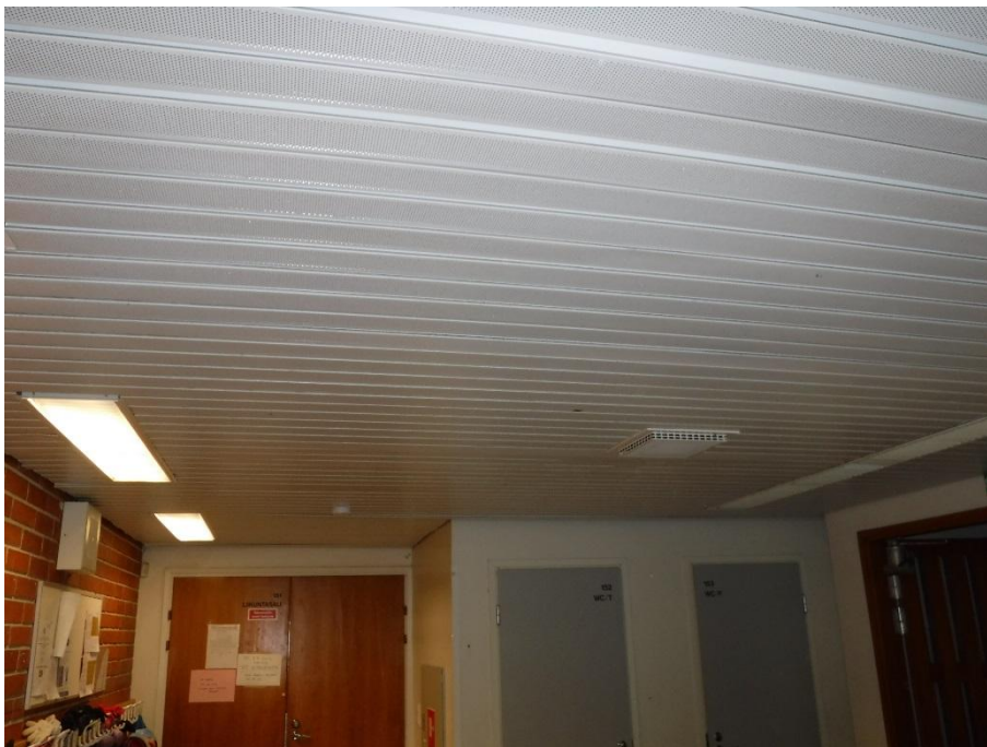
Kuva 25. Käytävien sisäkattojen alaslaskuna on metalliritilät.
