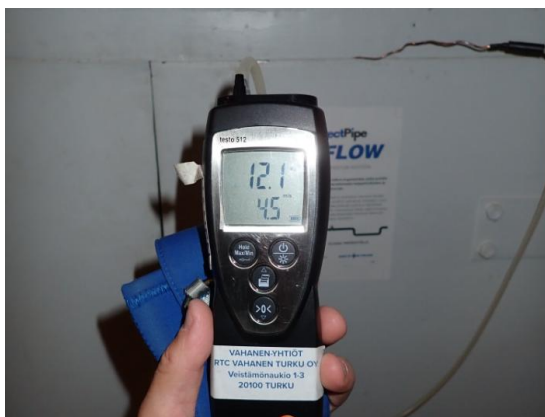
Kuva 2. Putkikanaalin ylipaineisuus suhteessa vaihteli välillä 8 – 16 Pa. Lämmönjakohuoneesta oli mittauksen aikaan ovet auki ulos asti, joten lämmönjakohuone oli vähintään hyvin lähellä ulkoilman painetta.
