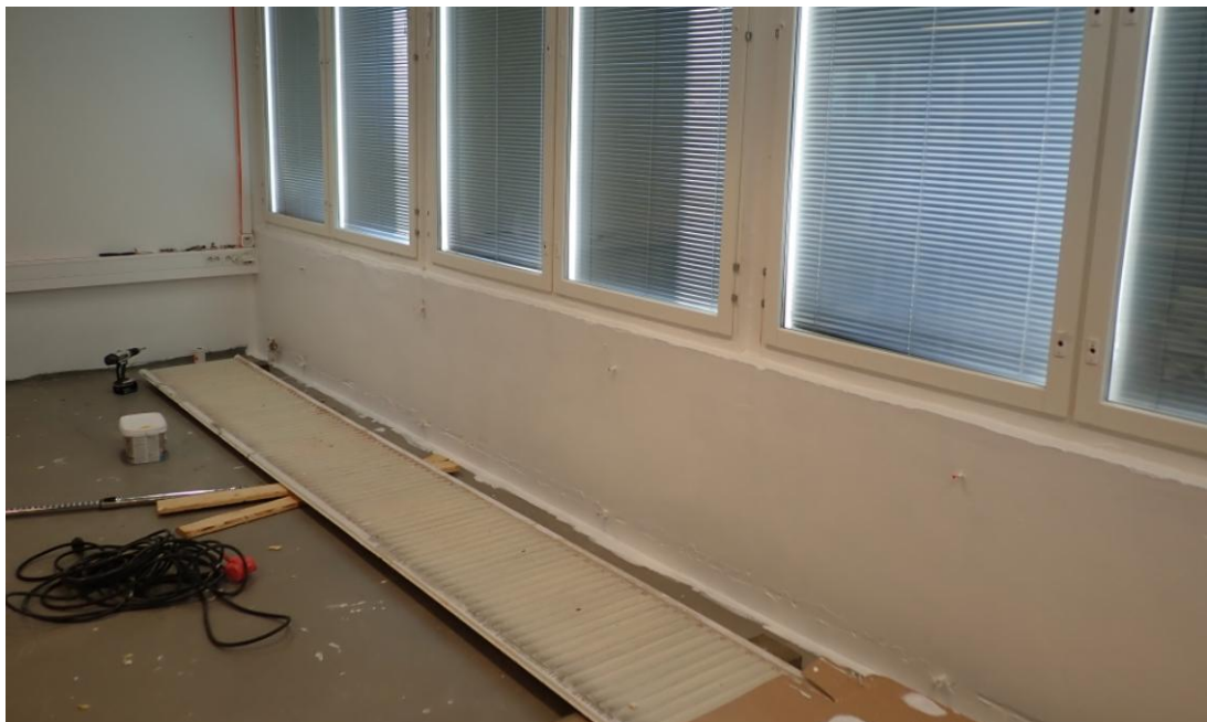
Kuva 3. Täydentäviä tiivistyskorjauksia varten vesikiertoiset lämmityspatterit oli pois- tettu paikoiltaan.
