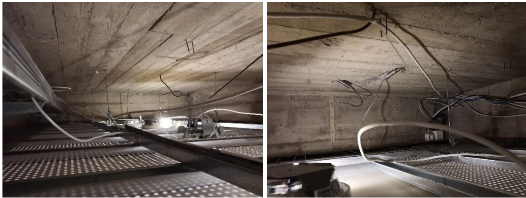
Kuvat 8 ja 9. Yleiskuva alakatosta (kuva 8). Välipohjassa olevia läpivientejä, joiden tiiveyttä ei päästy tarkastamaan (kuva 9).
