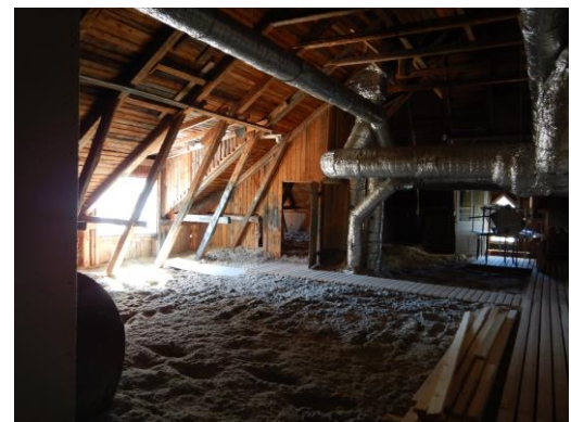
Kuva 26. Yleiskuva ullakotilasta. Yläpohjaan on lisätty puhellusvillaa.
