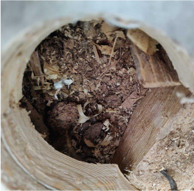
Kuva 13. Välipohjarakenteen VP3 rakenneavaus RA10
