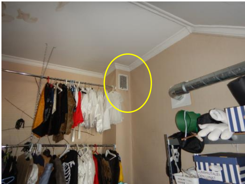
Kuva 27 Ummistamaton hormirakenne talomiehen asunnossa.
