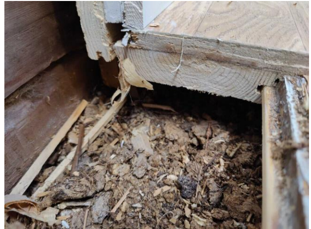
Kuva 15. Välipohjan lämmöneristeenä on käytetty turvetta.
