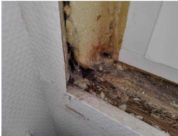
Kuva 8 Rakenneavaus RA13 tehtiin ikkunaliittymään esikoulun tiloissa.
