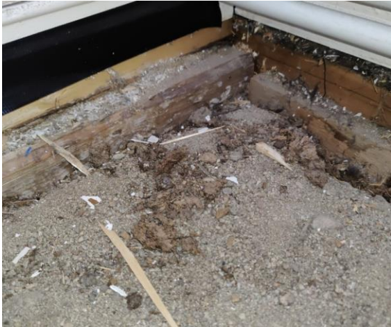
Kuva 14. Välipohjan orgaanisen lämmöneristeen päällä on paikoin käytetty hienoa hiekkaa.
