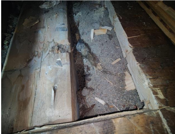
Kuva 11. Välipohjarakenne VP1, RA2
