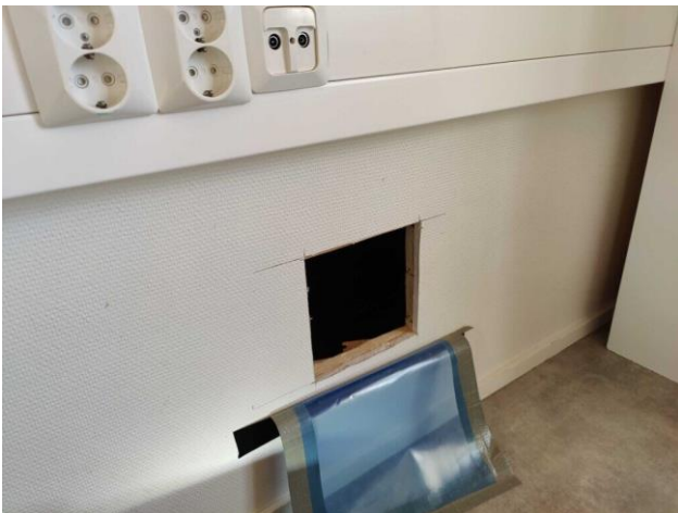
Kuva 19. Väliseinän VS2 rakenneavaus RA6
