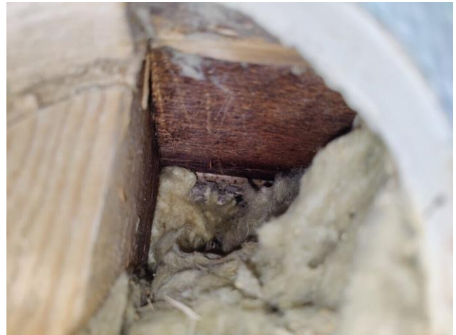
Kuva 9 Rakenneavaus RA12 toteutettiin ikkunalyhtyrakenteeseen.
