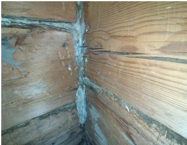
Kuva 6 Lahottajasienikasvustoa nurkkaliitoksen pellavariveissä. RA1.
