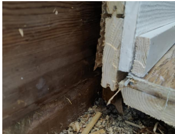
Kuva 7 Hirsirungon pintaan on koolattu laudoitus, jonka päälle on asennettu kipsilevytyks. RA8
