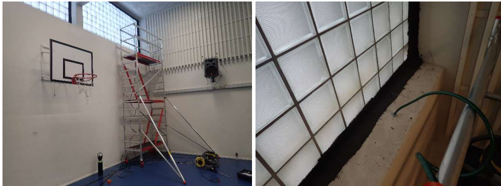
Kuvat 7-8. Liikuntasalin tutkimukset suoritettiin osin telineiden päällä. Seinän merkkiainetutkimuksessa kaasu syötettiin ulkoseinään porattujen porareikien kautta.
