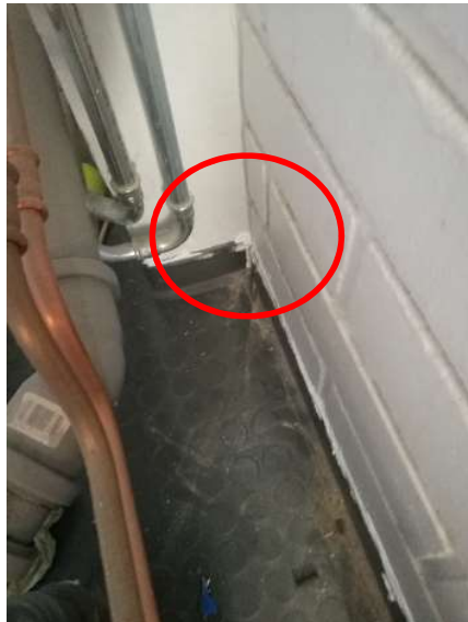
Kuvat 6 ja 7. Tilassa A206 havaittiin ilmavuotoja mm. ulkoseinän ja alapohjan liittymästä pilarin kohdalta sekä ulkoseinän ja ikkunapenkin liittymästä.
