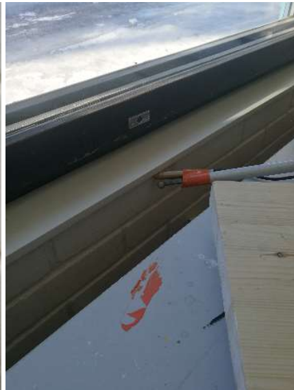
Kuvat 6 ja 7. Tilassa A206 havaittiin ilmavuotoja mm. ulkoseinän ja alapohjan liittymästä pilarin kohdalta sekä ulkoseinän ja ikkunapenkin liittymästä.
