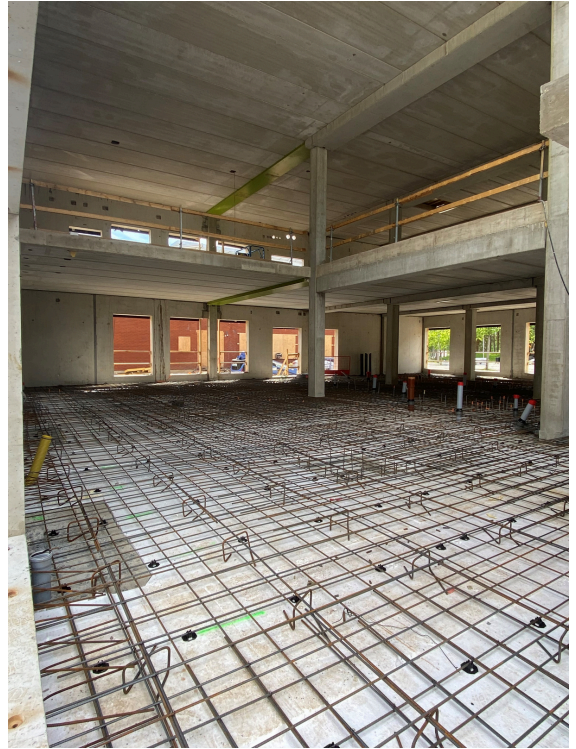
Alapohjan raudoitus käynnissä.
